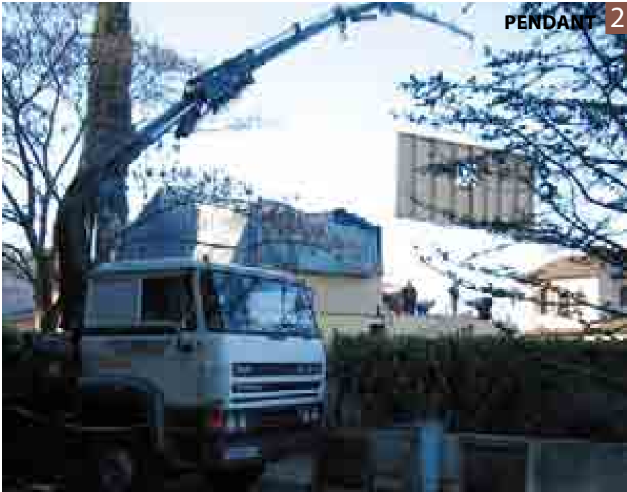
Une fois la partie en rez-de-chaussée débarrassée de sa toiture, les panneaux d'ossature bois, réalisés en atelier, sont livrés et mis en place à l'aide d'une grue.
