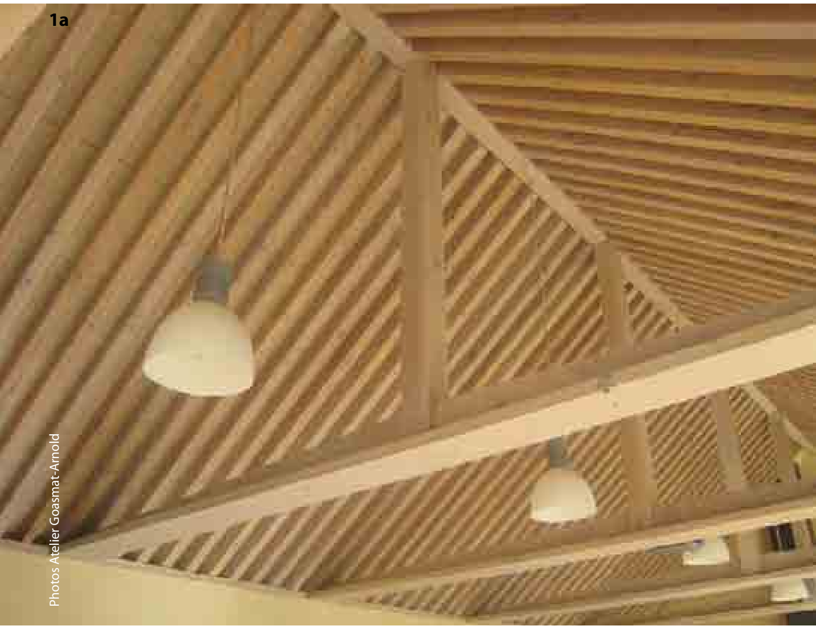
1 - Bâtiment d'accueil - 1a - Charpente à poinçon et entrait - Les arbalétriers sont remplacés par un pan de bois constitué d'un ensemble de solives bois de petites sections, posées tous les 30 cm. 1b - Gîtes - La charpente est réalisée avec une série de solives bois de petites sections, s'appuyant sur une panne faîtière. 2 - Les fermes sont constituées de fines sections carrées 12 x 12 cm, avec poinçon et entrait retroussé, disposées tous les 1,20 m. 3 - Les préaux : la forte présence du bois est «allégée» par la finesse des profils et le tissage du bois et de lumière.
