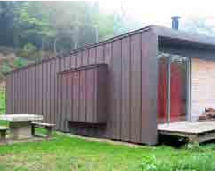
Les bardages sont réalisés en planche de pin Douglas sur les façades Est, Sud et Ouest. Le zinc recouvre et protège le côté Nord.
