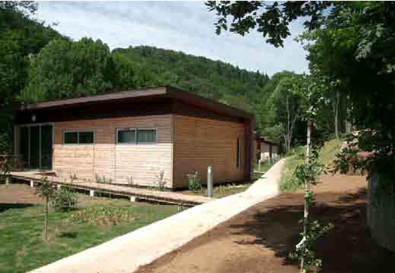
Les bardages sont réalisés en planche de pin Douglas sur les façades Est, Sud et Ouest. Le zinc recouvre et protège le côté Nord.
