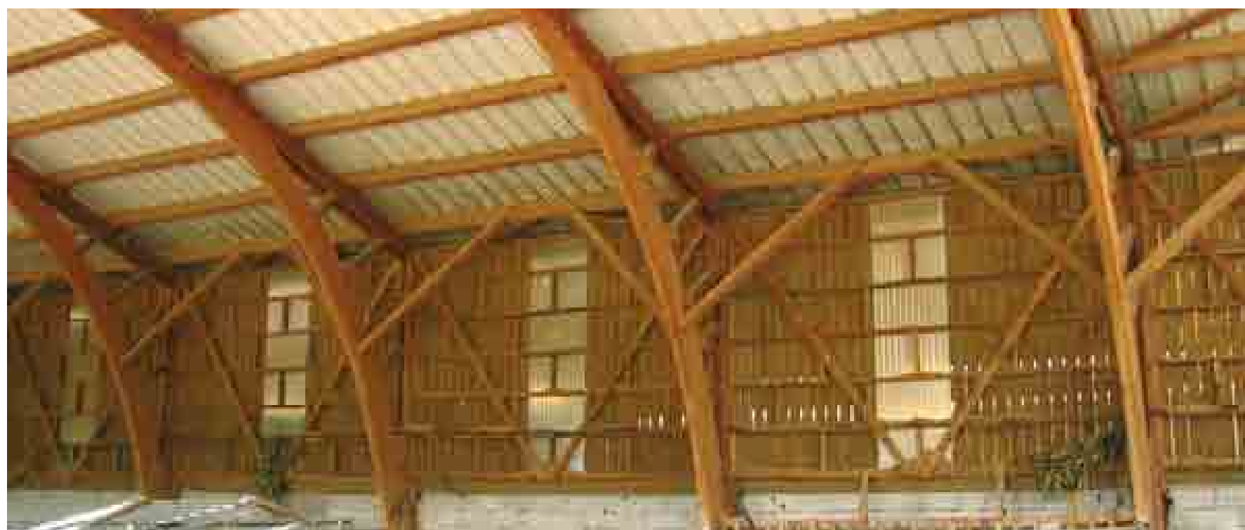
Chaque trame bénéficie d'un éclairage diffus au nord, constitué par l'interposition de plaques translucides de polycarbonate dans les éléments de bardage bois.
