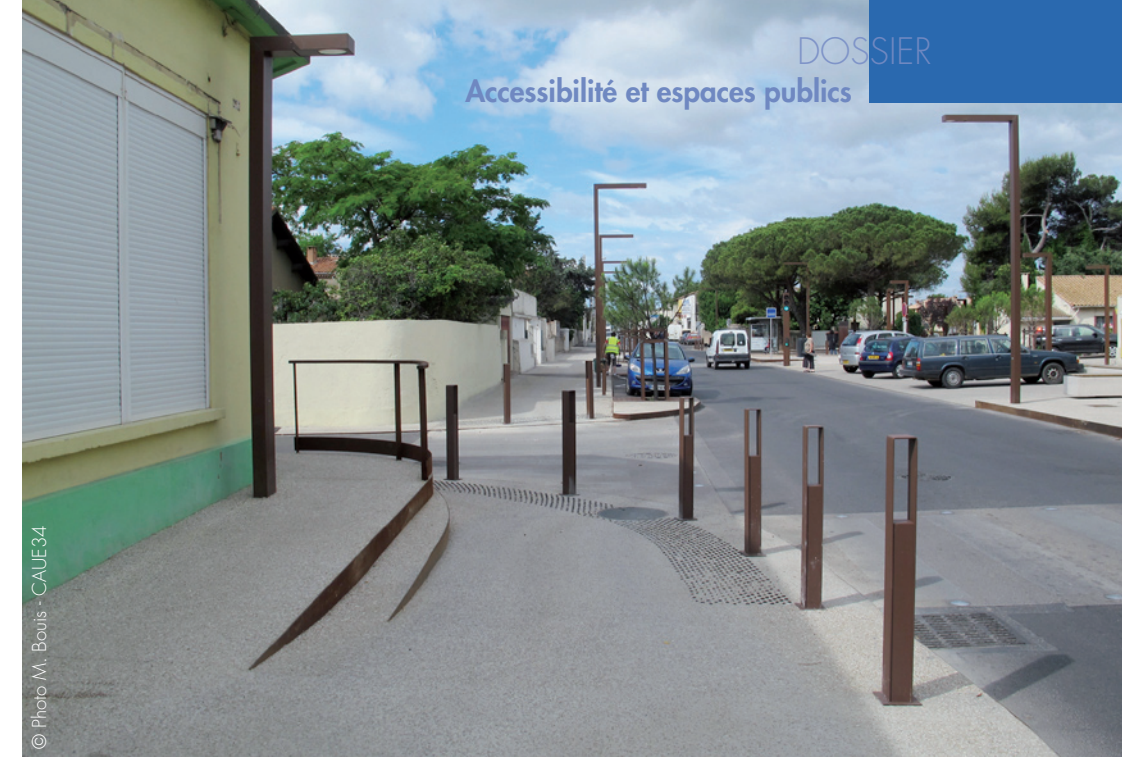
Frontignan - Une rampe d'accès à un commerce est conçue avec des bordures en acier Corten qui se font discrètes en limitant leur impact sur le trottoir. Nicolas Lebunetel, architecte.
