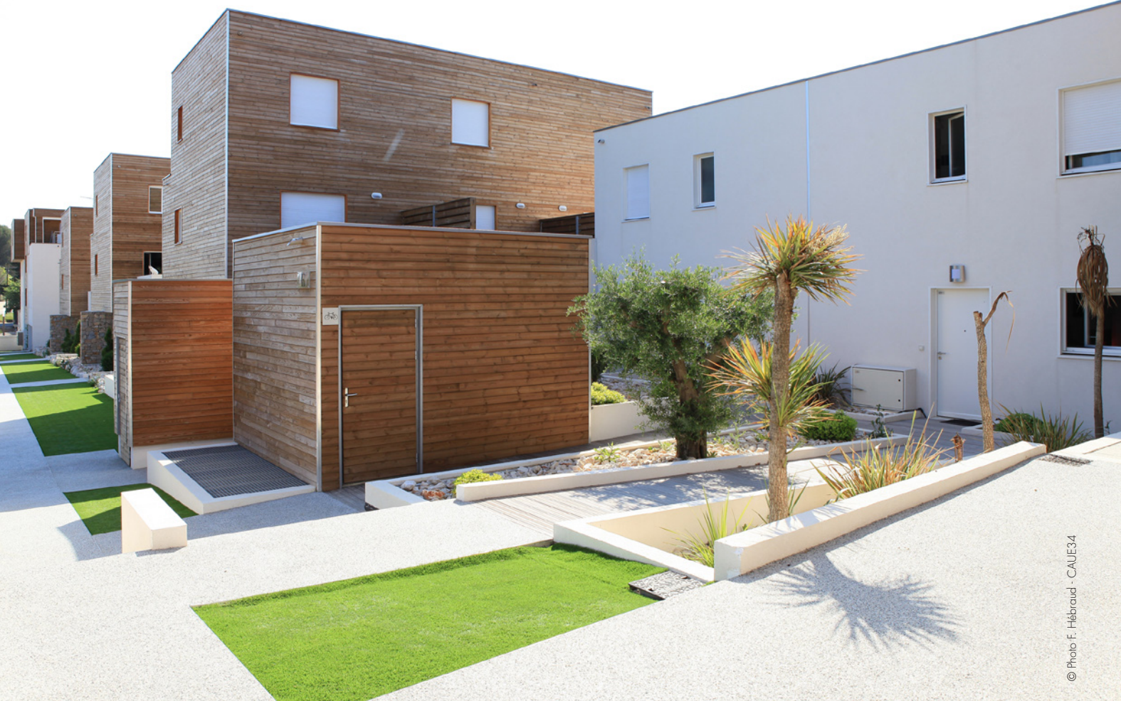
Façade Nord-Est - Une allée en pente douce dessert les logements à partir d'une voie piétonne, repoussée en limite de parcelle. Des bandes végétales doublées d'enrochements, maintiennent à distance les rez-de-chaussée de la circulation des piétons. Au premier plan, un local à vélos, revêtu de bardage bois, s'inscrit dans les volumétries de l'ensemble.
