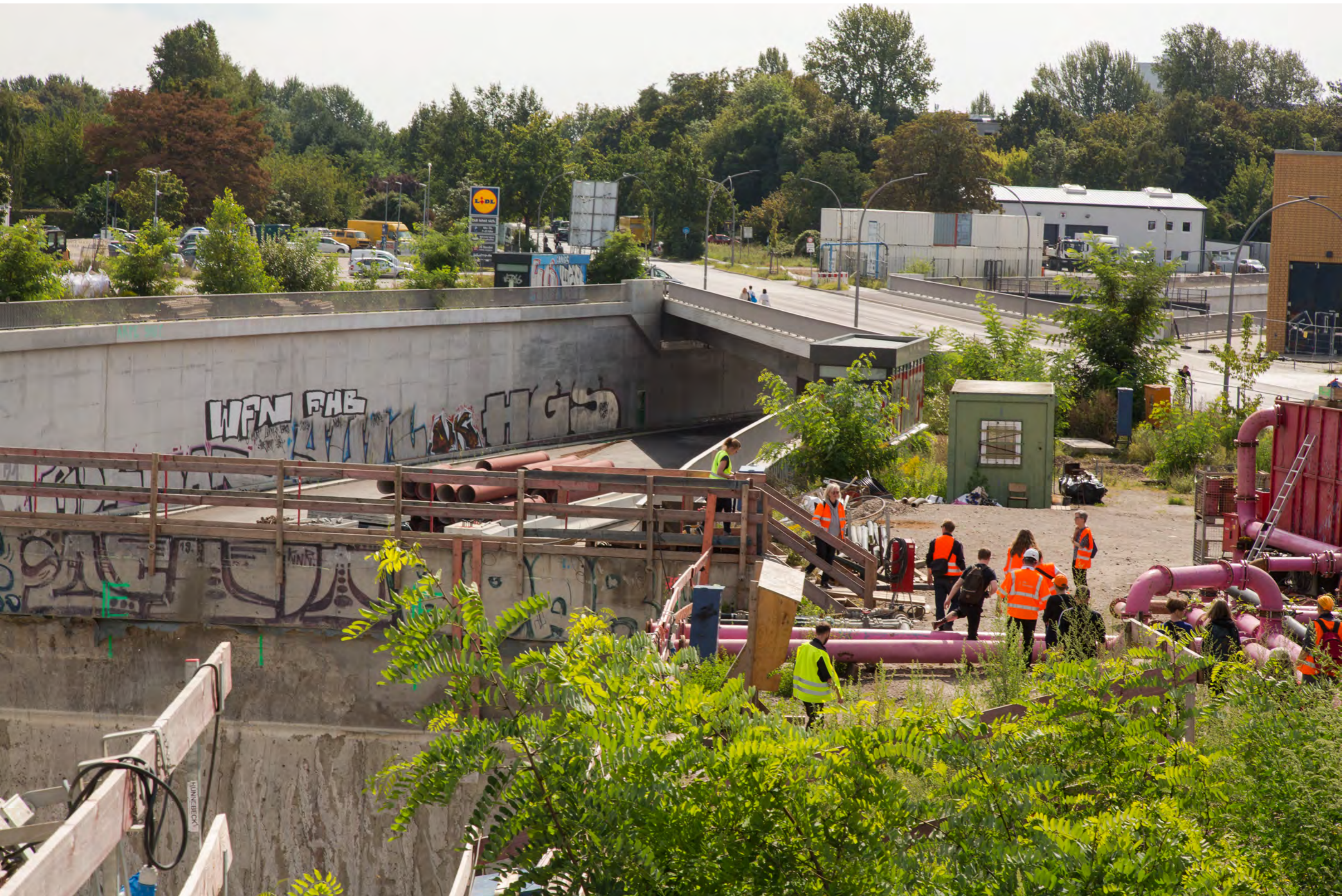
Visite guidée du chantier avec l'ingénieur en chef Thomas Heyder
