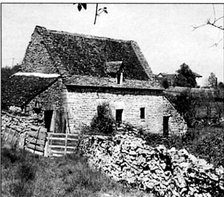
Rives et égouts en lauze calcaire
