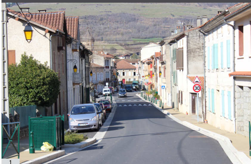
1. L'aménagement de la traverse du village prend en compte l'accessibilité et la sécurité
