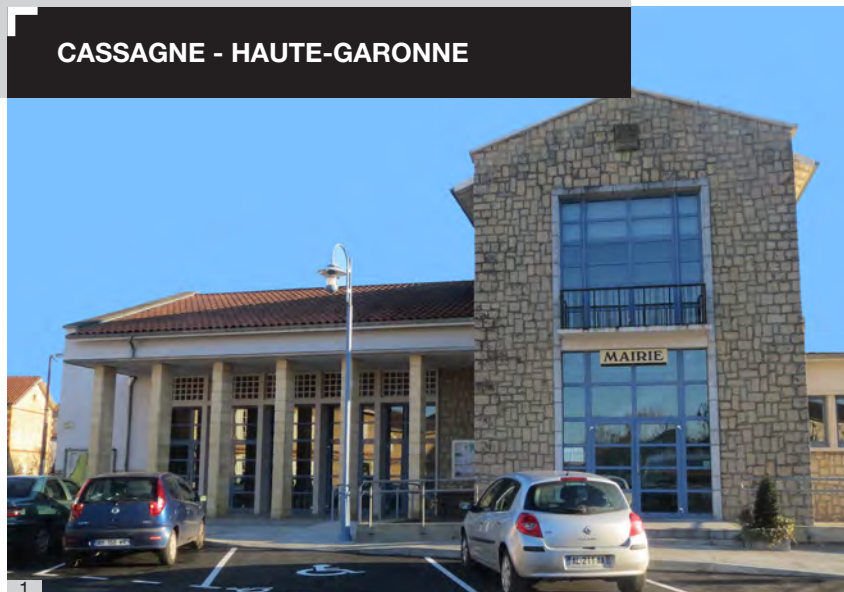
1. Façade principale de la mairie / salle des fêtes de Cassagne (31)
