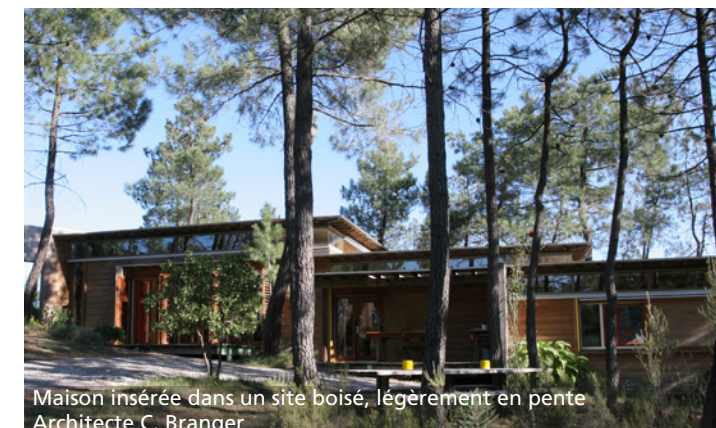
Façade principale ouverte sur le Sud Architectes Almudever et Lefebvre
