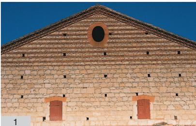
L'empilement des pierres se fait rang par rang sur un lit de pose au mortier de chaux à bain soufflant\*, avec peu de calage en fonction de la régularité des pierres.
