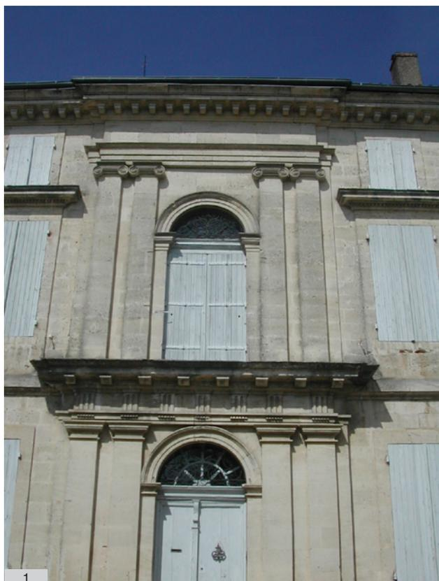
Les piédroits sont souvent montés en même temps que le mur, parfois avec un autre matériau. Les appuis peuvent être saillants et moulurés. Dans le sud du Tarn, les encadrements des ouvertures peuvent être en granit.
