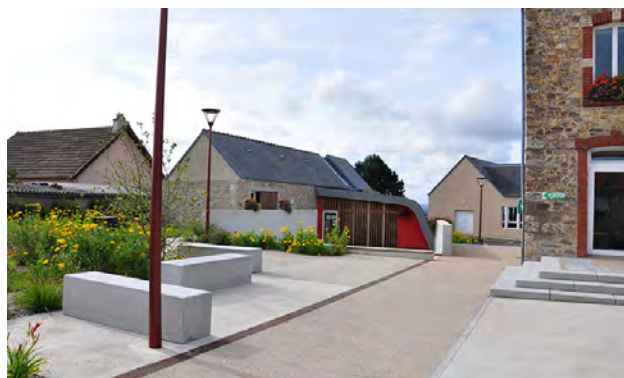
Reconversion d'un bâtiment communal en médiathèque et aménagement des abords - Flottemanville-Hague 50 - Atelier d'architecture Strates en Strates (Source Atelier Strates en Strates)
