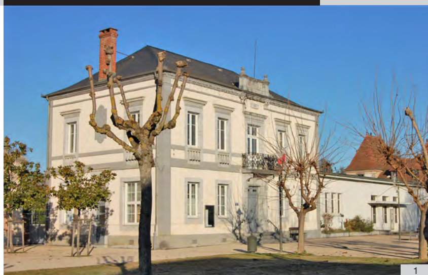
1. Façade principale sur la place centrale.
