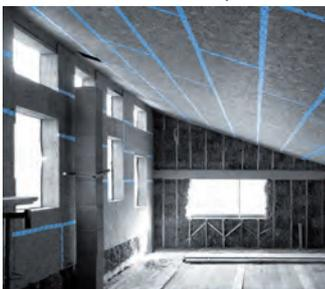
Lors de la construction d'une maison à ossature bois (ici isolée en paille), l'étanchéité à l'air entre panneaux est assurée par la pose d'un ruban adhésif.
