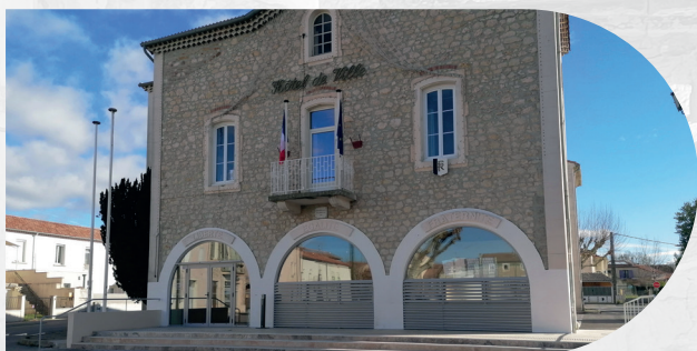
Alexis Champetier architecte HMONP Réhabilitation de la mairie de Salindres Salindres 30340 Maître d'ouvrage : Mairie de Salindres
