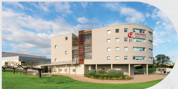
MN-Lab Architectes Rénovation du siège social d'Eminence Aimargues 30470 Maître d'ouvrage : Eminence group
