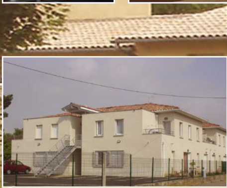
Résidence Edouard Forestié à Montauban Arch. : J.F. COMBES
