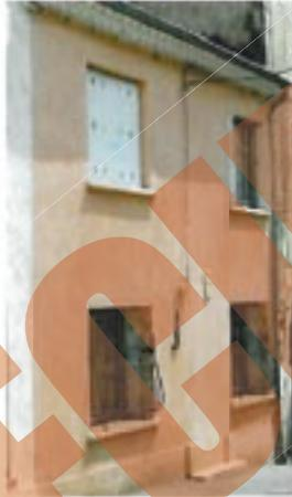
La porte d'entrée a été murée (on ne distingue plus que la clé de son linteau, les bases de ses jambages, son seuil) ; les fenêtres ont été élargies et leurs fermetures initiales ont été remplacées par des volets repliables à l'étage et des grilles de protection au rez-de-chaussée.
