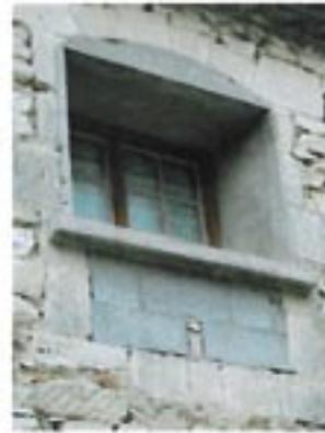
À éviter : ouverture anélagée en utilisant un ancien percement, sans le respecter (encadrement en pierre de taille, appui en ciment, transformation du linteau cintré en linteau droit, modifications des proportions de l'ouverture).
