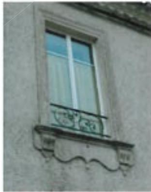
Fenêtre de proportions traditionnelles (plus haute que large), sécurisée par une barre d'appui.
