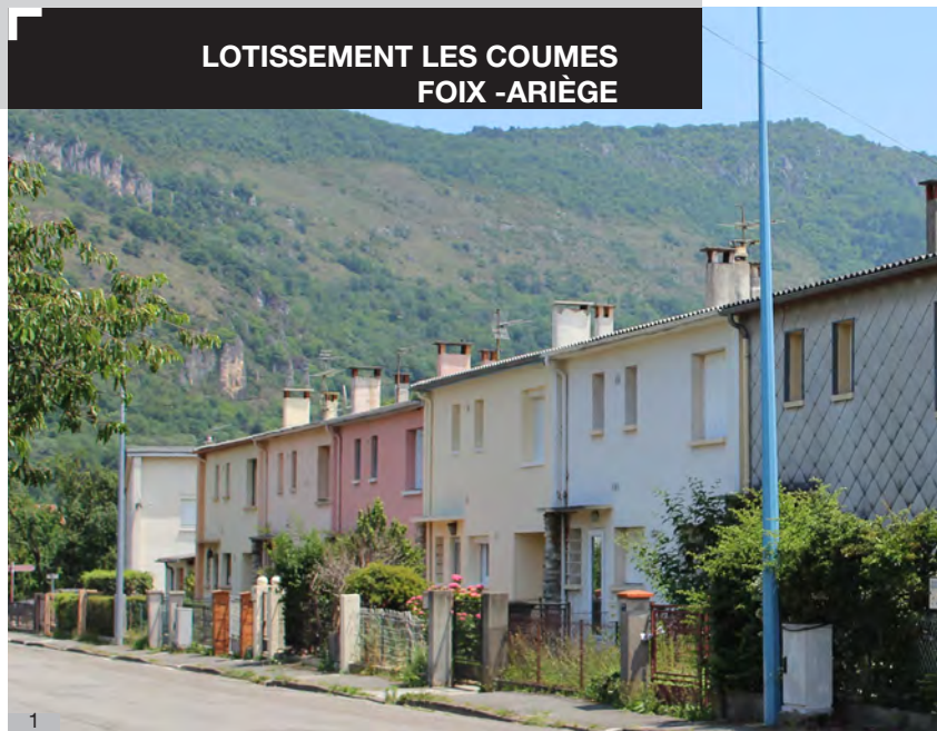
1. Vue sur une partie du lotissement des Coumes, façades Ouest
