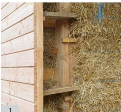
1. Détail du mur côté Ouest : paille et bardage bois
