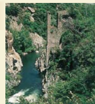
Pont des Sarrazins, ancien aqueduc à Rodès.
