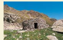
5 Orris, culeyas ou autres appellations selon les vallées, maçonnées en pierres sèches, en Conflent.
