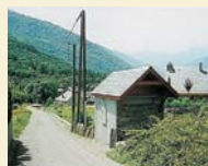
Intégration d'un transformateur électrique, Cierde-Luchon.
