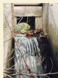
Déversoir sur le canal d'Ille.
