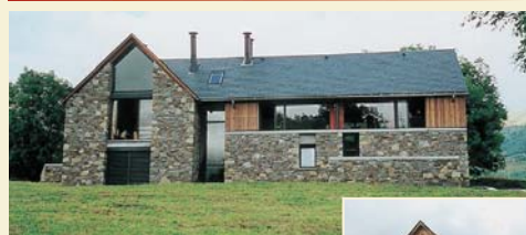
Construction nouvelle, Garin.
