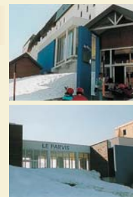
Les bâtiments de la station.
