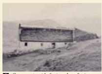
1 Grange protégée par le « fort », Gavarnie.
