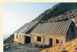
Vue du refuge côté façade principale et entrée.
