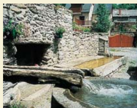
Aménagement d'un espace public, Cierde-Luchon.
