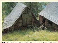
8 L'utilisation judicieuse du relief permet l'accès au fenil par le pignon arrière, grange, Le Playras.
