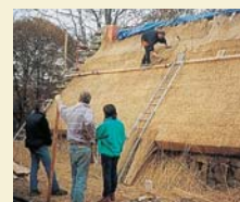
Création d'une toiture de chaume à Cominac.
