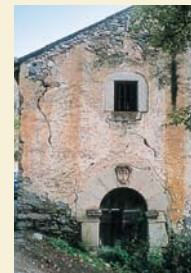
3 Encadrements en pierres de taille, ferme cerdane, Ilo.
