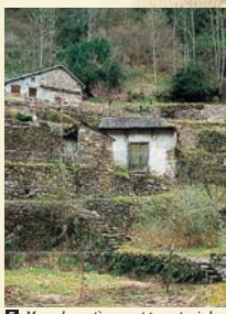
5 Murs de soutènement pour tenir les terrasses étroites reliées entre elles par des emmarchements en pierre, Coufflens.
