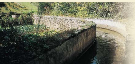
▲ Intégré dans une structure de terrasses de montagne, le canal de Céret coule d'Amélie-les-Bains à Maureillas. Il possède 13 aqueducs et plusieurs siphons, Pyrénées-Orientales.
