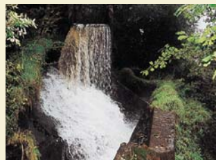
Siphon sur le canal de Bobère.
