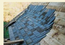
Détail de la technique de pose « à pureaux dégressifs ».
