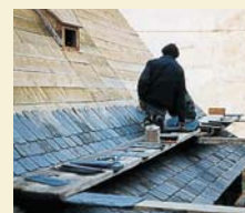
Chantier de pose.
