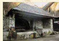
5 Lavoir à Arraut
