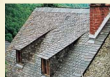
Toiture avec outeaux réalisée dans le cadre de l'opération ardoise.
