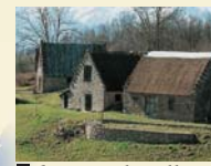
7 Couverture en chaume bloquée en pignon par les « pas d'oiseaux » ou « penaois », Cominac.
