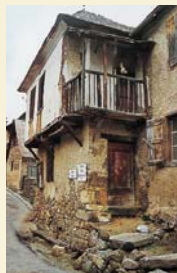
1 Usage du bois dans la construction : ossature à pans de bois en encorbellement, galerie, menuiseries, Arrien.
