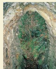
Tunnel sur le canal de Finestret.
