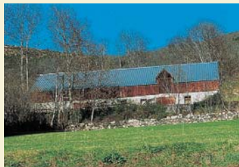
Bâtiment d'exploitation à O6, Haute-Garonne.
