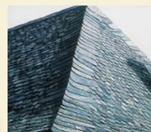
Toiture à trois pentes.
