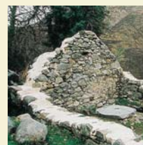
Maintien et consolidation des maçonneries existantes.
