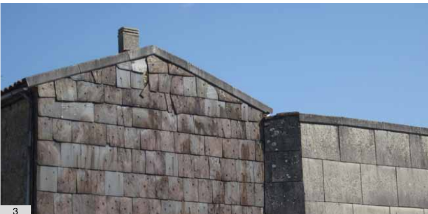
3. A côté de l'ardoise, l'essentage peut être en matériaux synthétiques, Montredon-Labessonnié, 81
