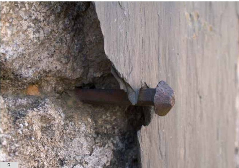
2. Clou forgé à tête ronde maintenant une plaque d'ardoise, Arfons, 81
