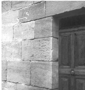
*Les maçonneries en pierres de taille se suffisent à elles mêmes. Il serait dommage de les cacher par un enduit.*
