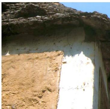
Maçonnerie de pierres retouchées souvent montées à l'argile, et enduites d'un mortier à chaux et à sable.
