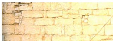
Maçonnerie de pierres équarries montées à l'argile ou à chaux et à sable.
