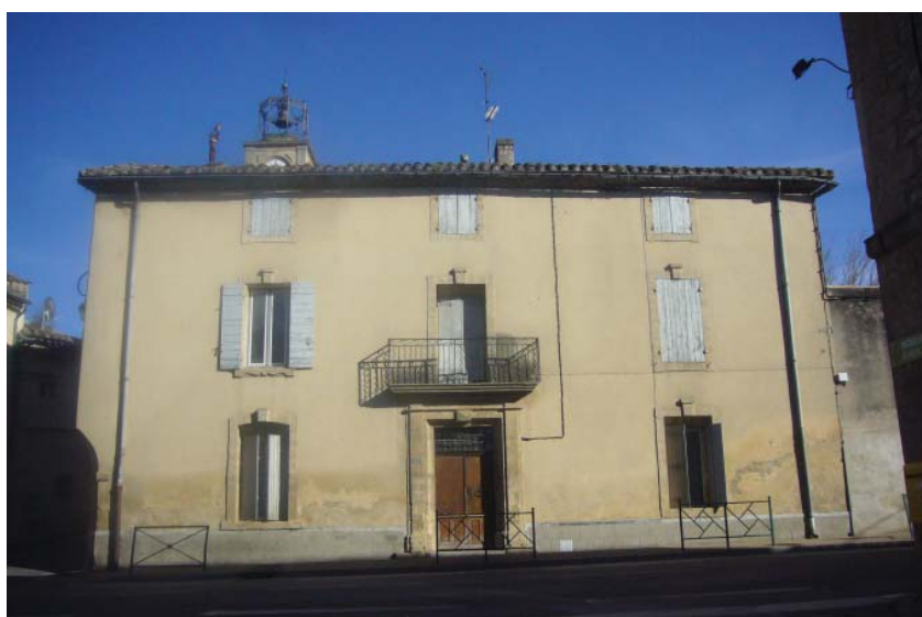
Façade ordonnancée aux dimensions des fenêtres diminuant au fur et à mesure des étages, tout en respectant les proportions (ici à Saint-Bonnet du Gard)
