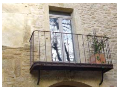
Balcons sur consoles métalliques et garde-corps de ferronnerie
