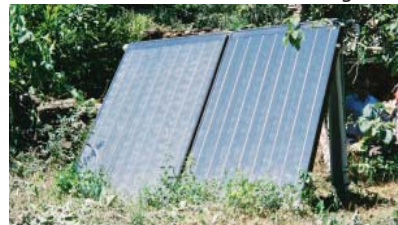
Capteurs plans en complément de chauffage
