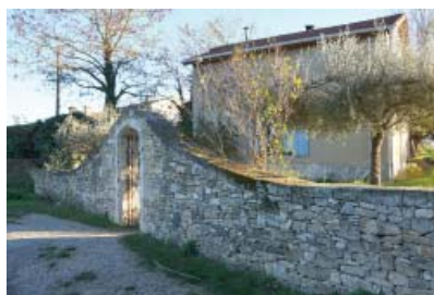
Mur contemporain en pierre sèche à Collias
