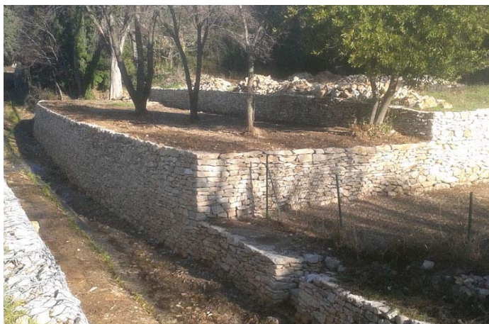
Murs de soutènement en bordure de ruisseau à Cabrières
