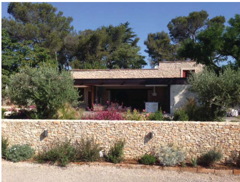
Extension contemporaine de maison de garrigue, Benoit Gillet, architecte Ecriture longiligne, parallèle au mur de la façade principale, toiture terrasse, matériaux bruts, caractérisent cette extension réussie d'une maison typique de garrigue
