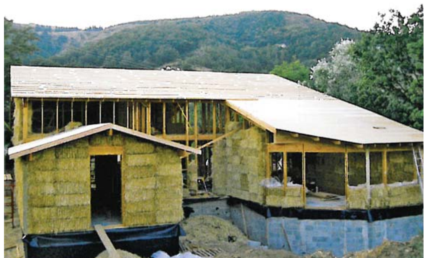
Construction d'une maison à ossature bois et bottes de paille
