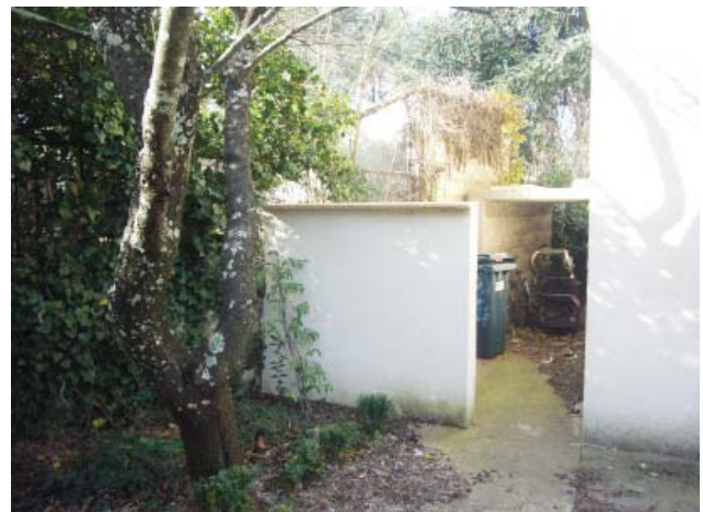
Contenars à ordures dissimulés par un muret
