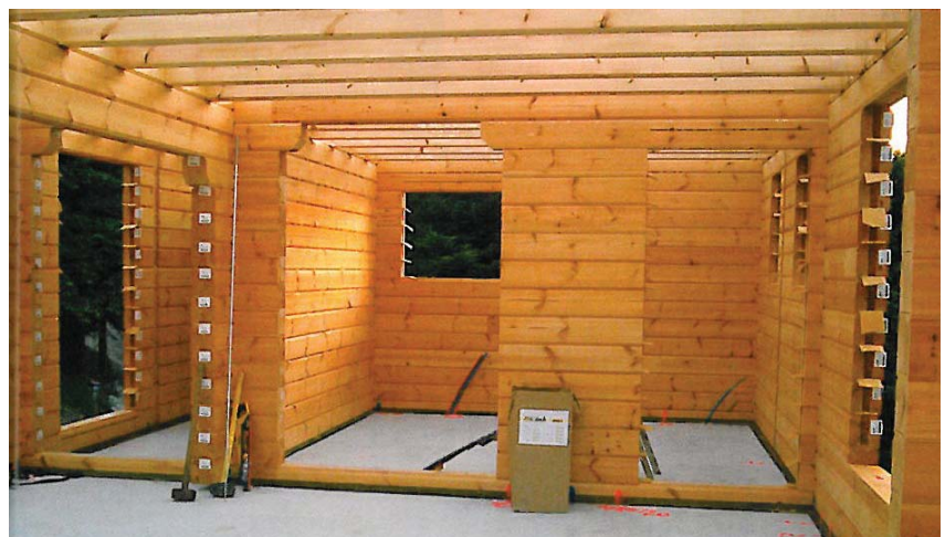
Construction d'une maison en madriers empilés, bois massif
