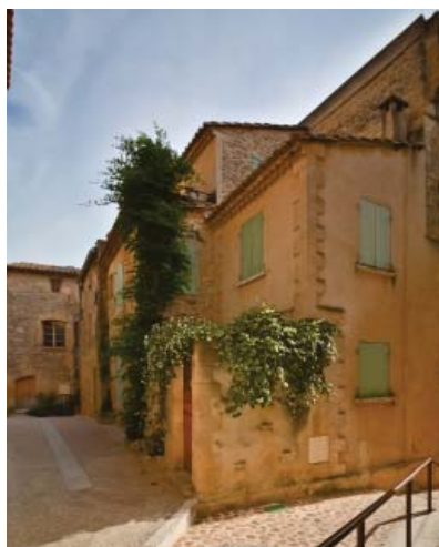
La suppression ou l'encastrement des réseaux permet d'épurer la façade et lui redonne toute sa lisibilité. Elle accompagnera les travaux de ravalement, pour redonner au lieu qualité et sérénité (Vers-Pont du Gard)
