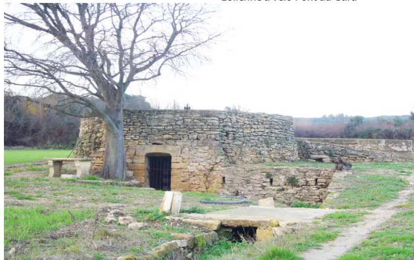
Noria à Vers-Pont du Gard ...
