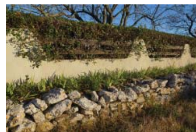
Mur clapier à Sanilhac-Sagriès
