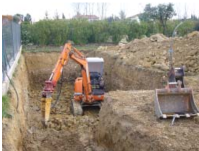
Chantier d'une citerne destinée à la récupération des eaux de toitures de hangars
