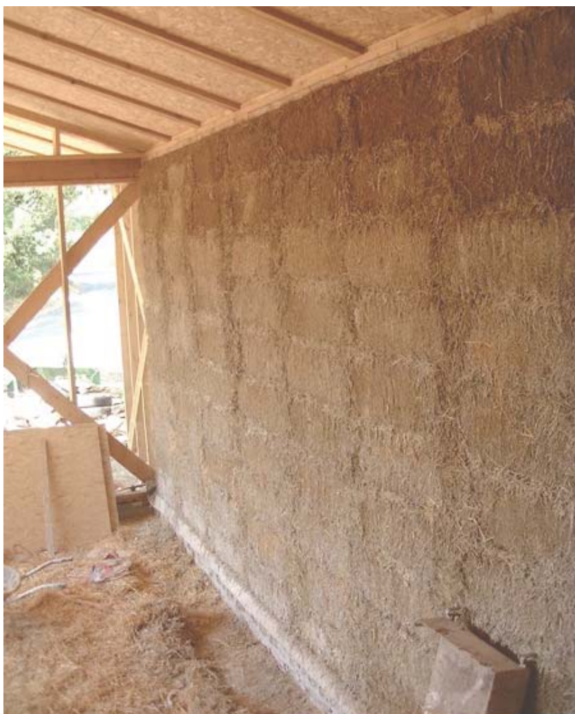
Mur en bottes de paille avant enduit
