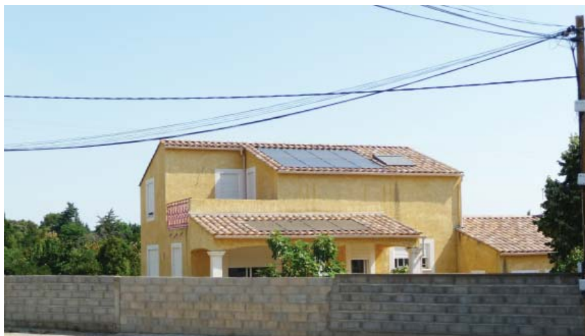
Tuiles canal et capteurs solaires cohabitent difficilement
