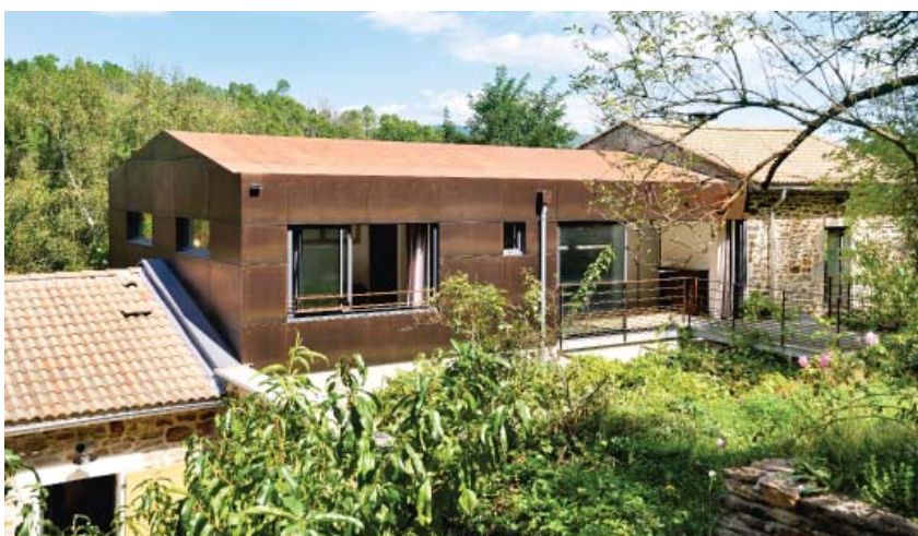
Extension, architecte Yann Roubeau Avant et après extension... ou comment apprécier une rénovation réussie !
