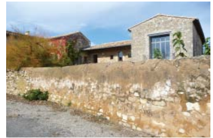
Préservation de murets de pierres sèches servant aujourd'hui de clôture de propriété, en l'état ou enduits à pierre vue
