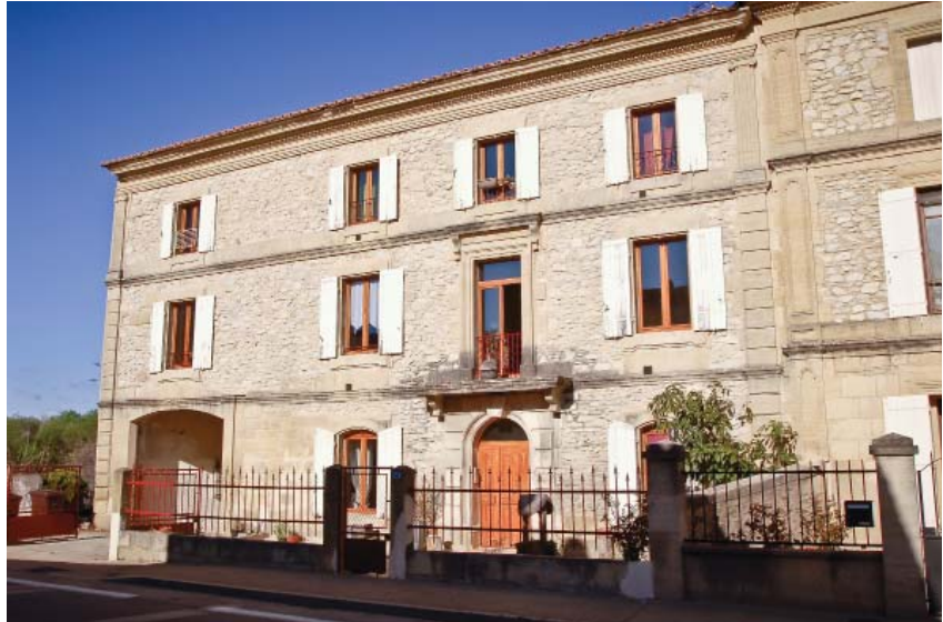
Maisons bourgeoises, "classiques" (ici à Saint-Bonnet du Gard)...
