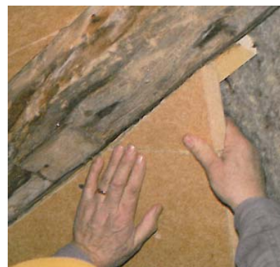
Isolation avec panneaux en fibre de bois
