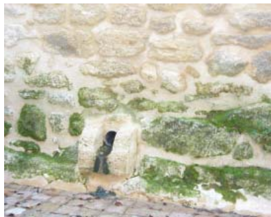
Une pierre taillée posée au ras du revêtement de la rue accueille la descente des eaux pluviales de ce bâtiment ; une manière élégante de canaliser ce réseau
