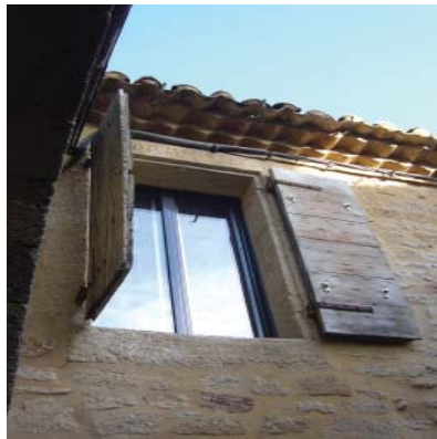
Volet à lames verticales, à clés et emboîture
