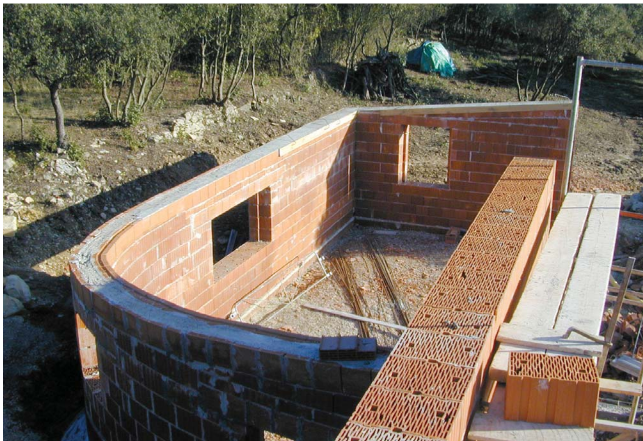
Réalisation de parois en briques de terre cuite alvéolées
