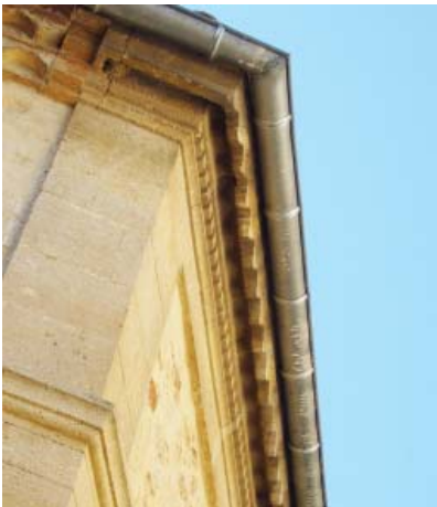
Corniche en pierre moulurée avec chevrons en saillie protégés par des lambrequins en bois
