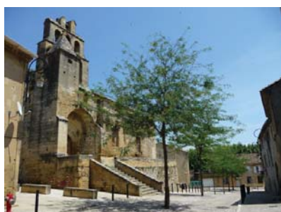
Place de l'Eglise en bordure du noyau médiéval
