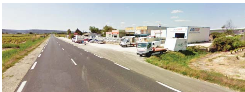
Bâtiment d'activités au bord de la RD 6086, sur la commune de Lédenon
