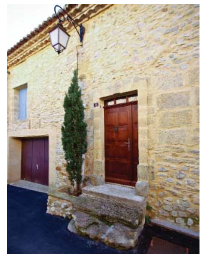
Bon exemple de porte pleine à panneaux avec imposte vitrée
