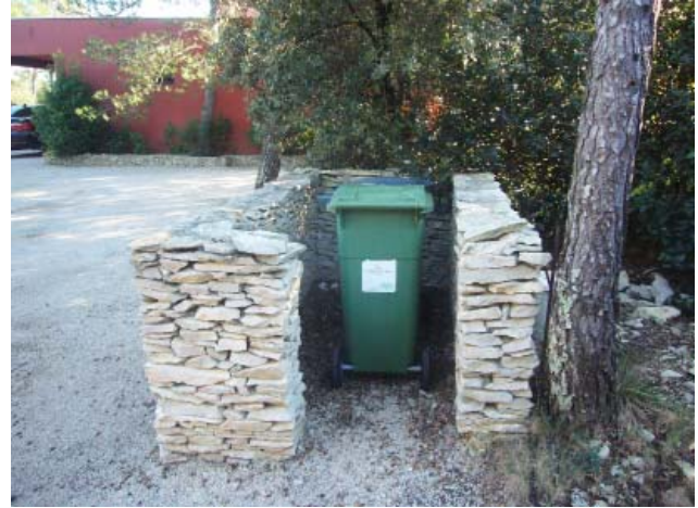
Contenars à ordures dissimulés par des murets de pierre sèche en bordure du parking
