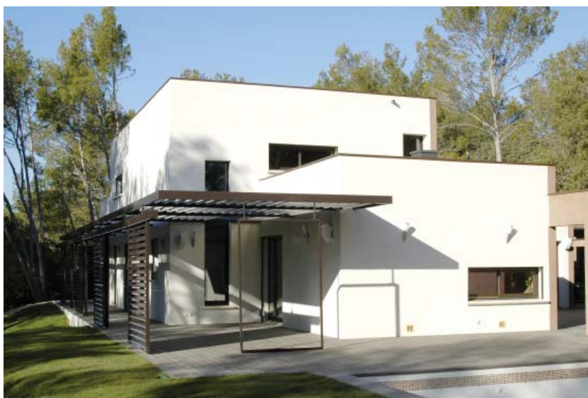
Villa conçue par Quaillemonde Architectes Volumétrie simple de cubes imbriqués, jeu des ouvertures "bandeaux", positionnées tantôt à l'horizontale, tantôt à la verticale, jeux d'ombre et de lumière qu'offre la pergola et de ses éléments persiennés, contribuent à l'harmonie de cette villa
