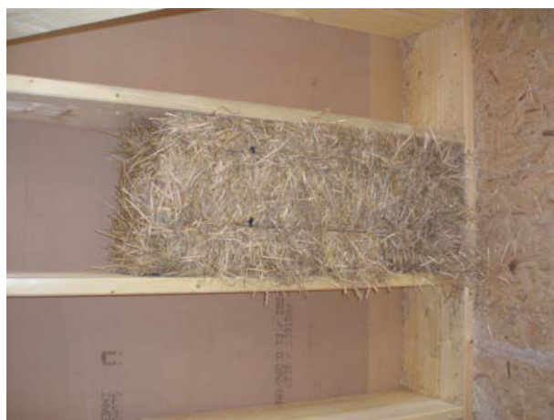
Remplissage d'une ossature bois par des bottes de paille
