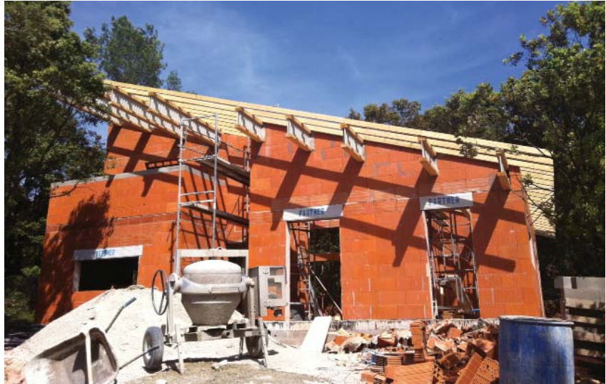
Maison Cabrol à Saint-Gély-du-Fesc (Hérault), lauréate du concours BBC catégorie "Construction BEPOS". Murs extérieurs en briques à joint mince de 20 cm + un isolant naturel (mélange de chanvre et fibre de bois) de 100 mm à l'intérieur Architecte : Marie Orssaud
