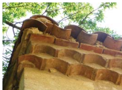
La génoise traditionnelle, composée de tuiles rondes superposées, présente des éléments de terre cuite apparents, l'enduit de bourrage laissant visible la tranche des tuiles
