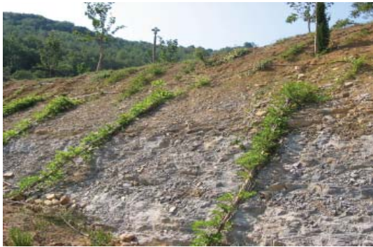
Bignone remplissant ici une fonction utilitaire : couvrir le talus pour lutter contre l'érosion
