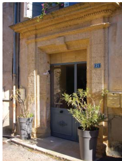
Bon exemple de porte vitrée se mariant bien avec la pierre existante. On regrette le traitement de l'imposte pleine : la menuiserie ne respecte pas la dimension de l'embrasure d'origine
