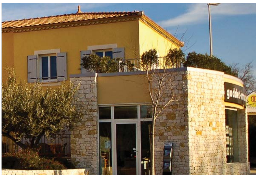
Terrasse aménagée sur rez-de-chaussée commercial à Poulx
