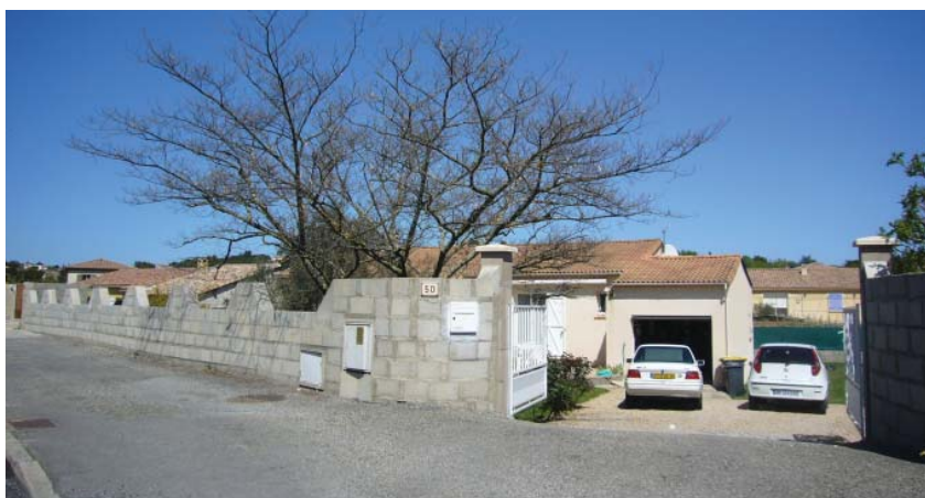
Lorsque les clôtures ne sont pas enduites, elles appauvrissent l'espace public
