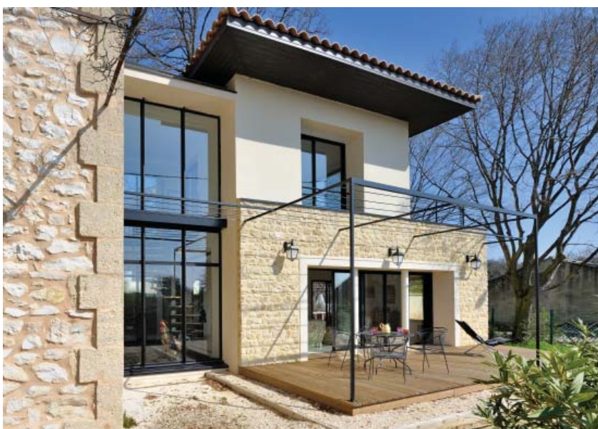
Armature contemporaine en harmonie avec l'architecture
