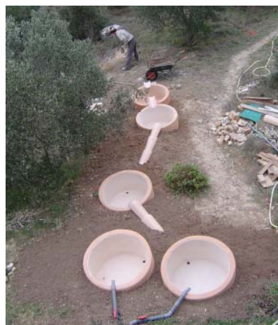
Réalisation de bassins-filtres (Ø:1m)
