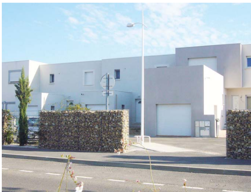
Ici des gabions, non pas utilisés en parement de façades mais en murs de clôture (ZAC des Ferrières à Bellegarde)
