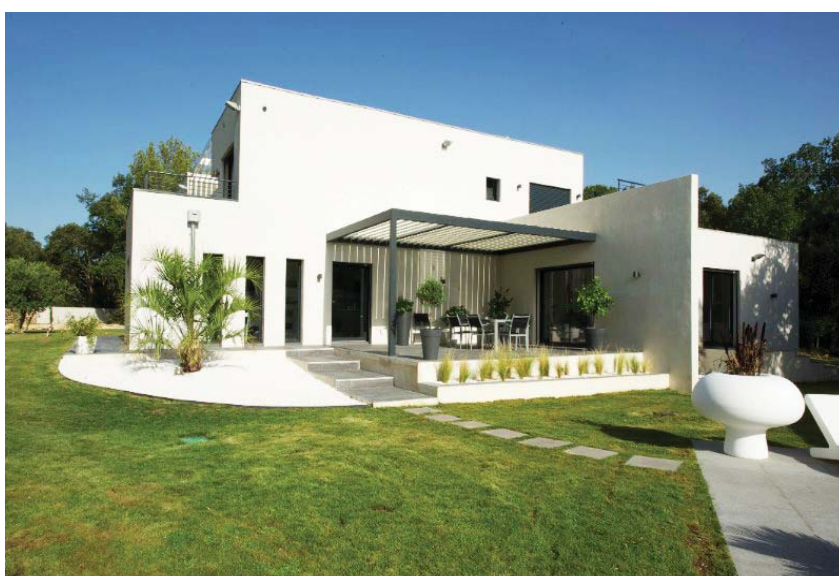
Une structure métallique recouverte de plaques de polymères translucides qui s'accorde bien avec le style contemporain de la maison
