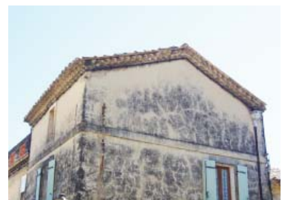
Génoise se prolongeant sur le pignon
