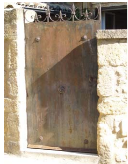
Portail métallique d'aspect "rouillé" à prendre en exemple
