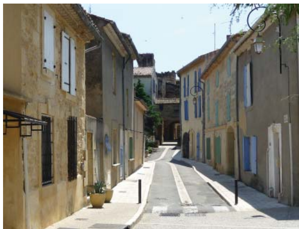
Remoulins : un exemple simple d'aménagement de rue qui organise les différents usages (trottoirs, chaussée, caniveau...) et met en valeur les façades.
