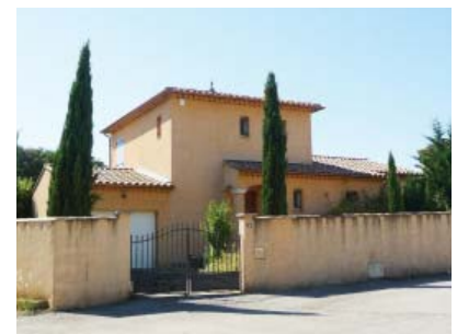
Attention de ne pas abuser du toit à 4 pans sur de petits volumes
