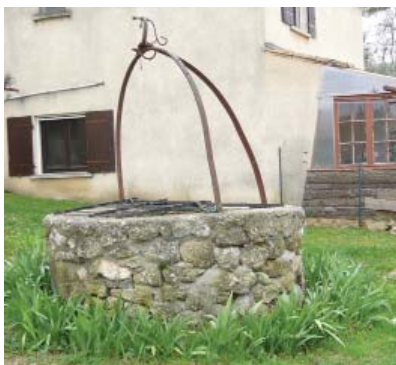
Puits à Dions
