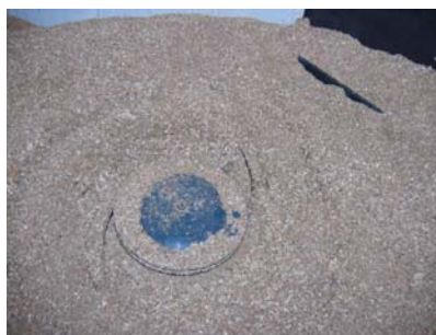
Râcleur dans un silo de stockage de copeaux (plaquettes)
