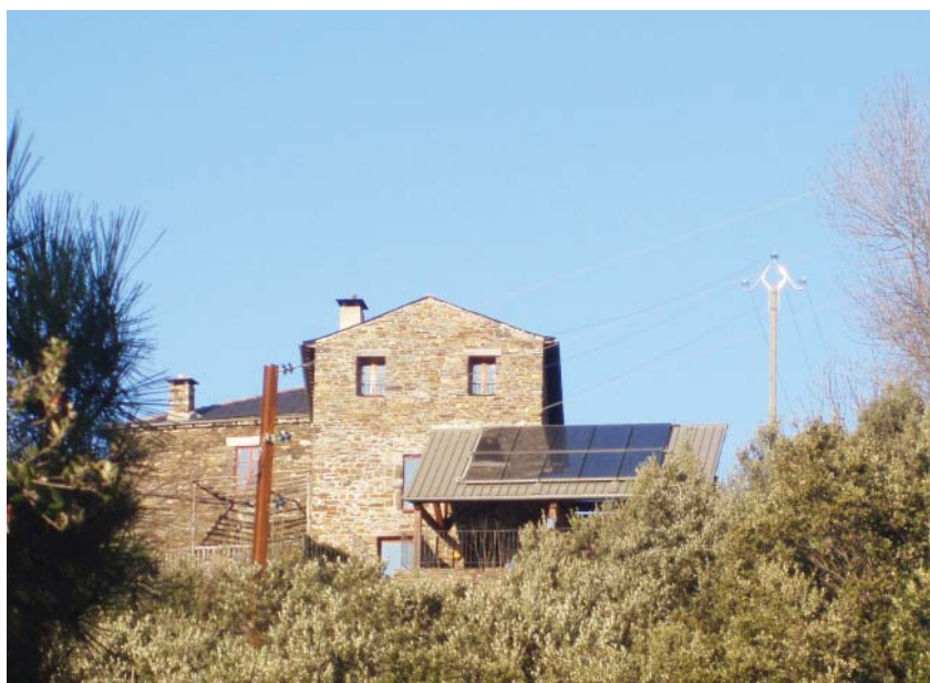
Exemple d'une pose bien intégrée sur une extension avec couverture en zinc
