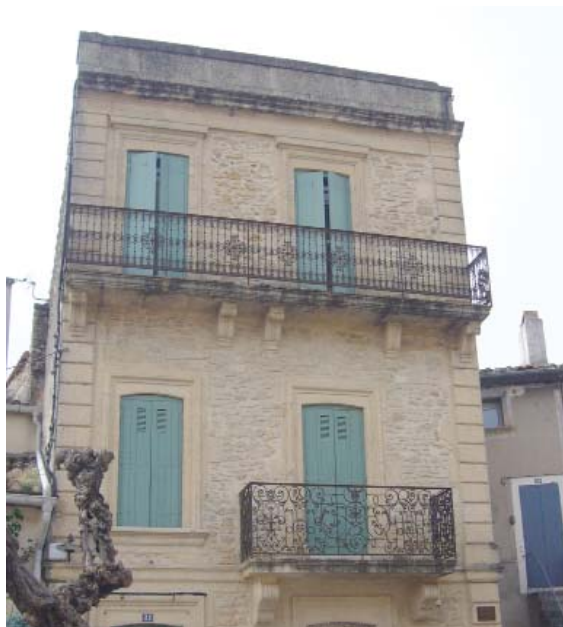
Balcons en pierre sur consôles pierre et garde-corps de ferronnerie ouvragée
