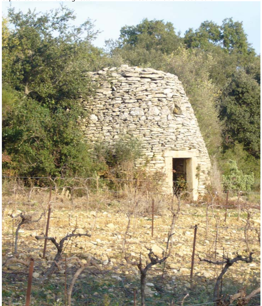
Capitelle à Vers-Pont du Gard
