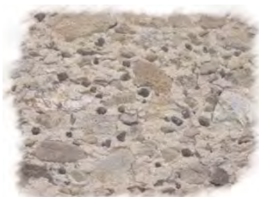
Incrustations de scories dans les joints
