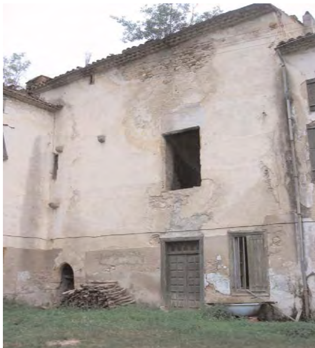
Ganac, partie la plus ancienne du château
