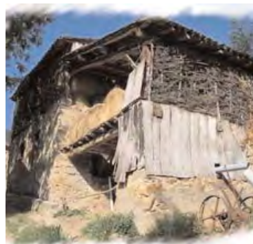
Bardage bois et branchages
