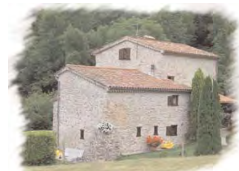
Façade postérieure, moulin de la Nation, Ganac
