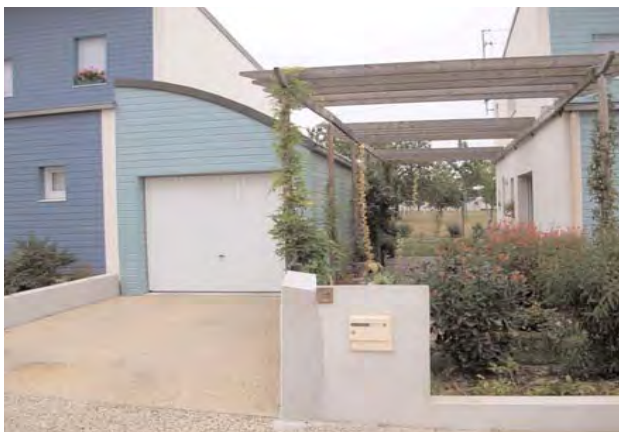
Détail sur les accès, Saint-Herblain (44)
