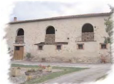
La grange, façade principale
