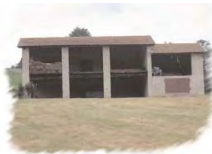
Hangar et granges, façade principale
