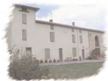
Ferme, façade principale
