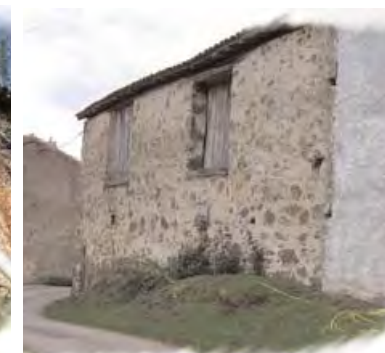
Mur postérieur d'une ferme enduit à la chaux
