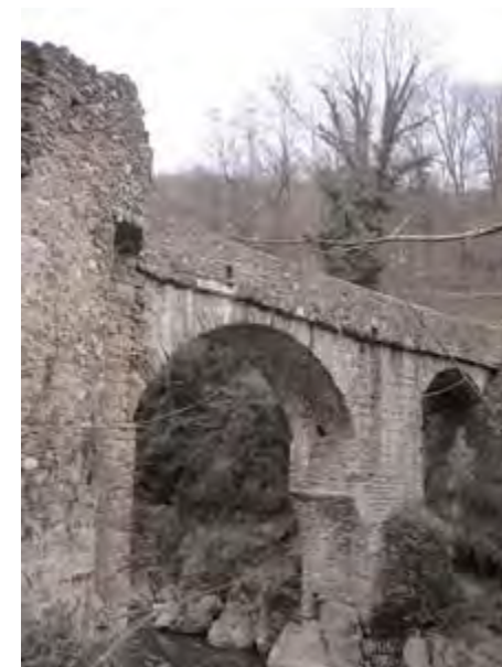
Le pont du Diable, Montoulieu
