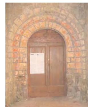
Porche d'entrée, église de Bénac
