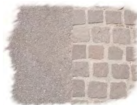
Association de pavés et de bitume
