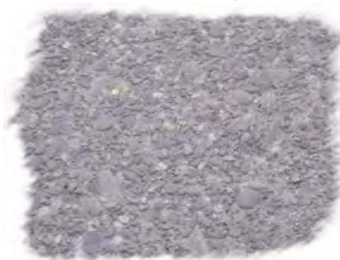
sol en béton désactivé
