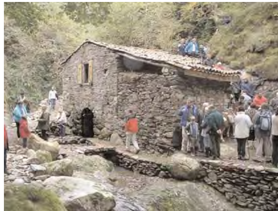
Le Moulin de la Laurède le jour de son inauguration (photo : Association du Moulin de la Laurède)
