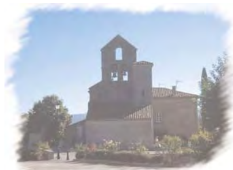
façade occidentale, église de Bénac
