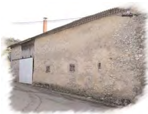
Ferme façades post. à Cos
