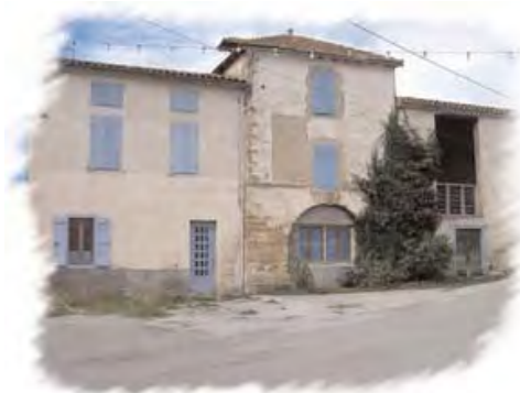
Ancienne ferme, façade principale
