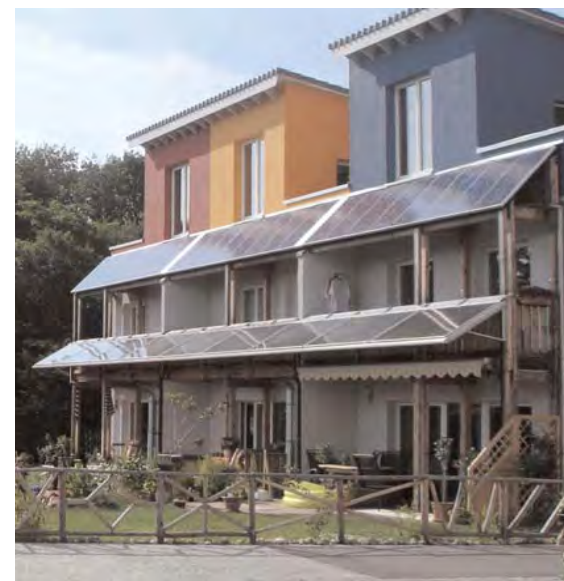
Projet d'habitat collectif ayant intégré le principe des énergies renouvelable dès la conception du bâtiment Rieselfeld - Fribourg-en-Brisgau (Allemagne)
