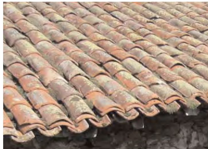
Toiture en tuile canal, Peyroutéoux, Burret
