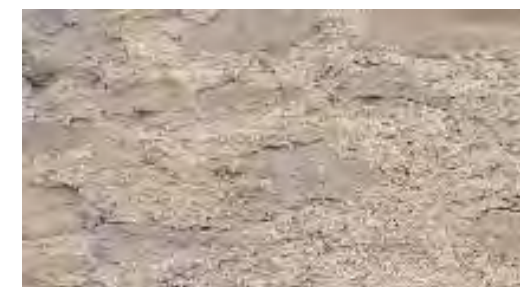
enduit à la chaux dont l'usure naturelle fait apparaître certaines pierres
