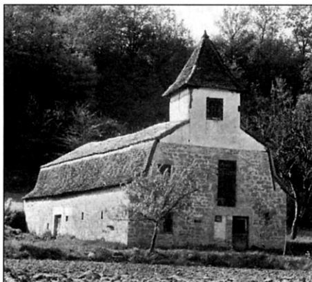
Toit à la Mansart
