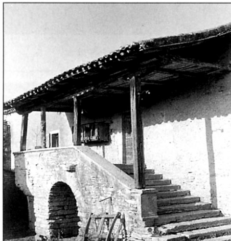
Charpente extérieure de "bolet"
