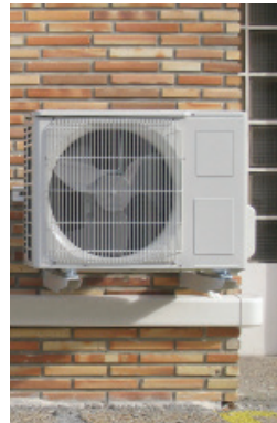
pompe à chaleur
