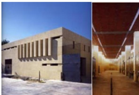
Comme pour la réalisation de son chai à Vauvert, Gilles Perraudin a utilisé ici la pierre massive de Vers-Pont-du-Gard. Des éléments de 2,20 x 0,65 x 0,90 m supportent les poutres principales en béton armé du toit terrasse. Les blocs ont été dressés à l'aide d'une grue mobile, les joints réalisés à la chaux.
