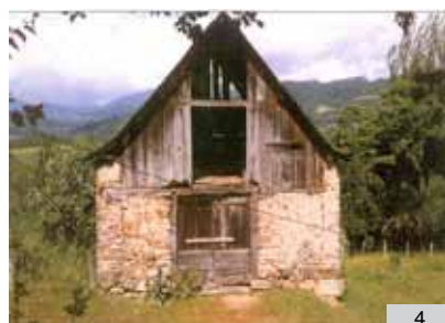
3. Grenier séchoir, Tarsac 32 4. Traitement courant en pignon, fenil de grange, Haut-Couserans 09
