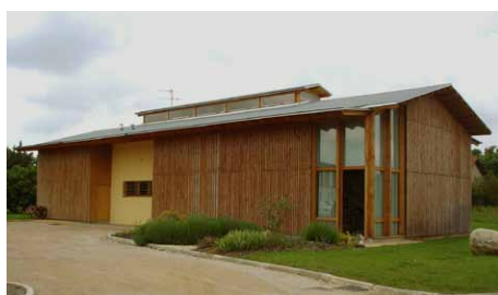
Bâtiment d'activités à Montauban Arch. : M. CHEREAU
