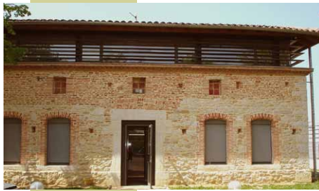
Communauté de communes du Quercy Caussadais à Caussade Arch. : B. SALOMON
