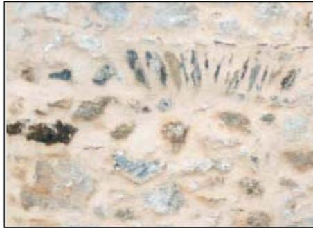
Exemples de joints de maçonnerie en creux à gauche, et de "remplissage", à droite
