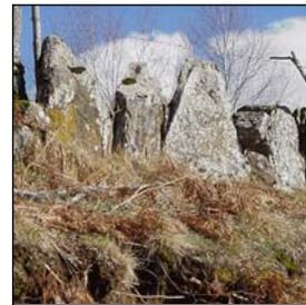
Clôture de pierres plates posées sur chant, Arrien
