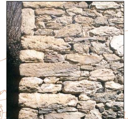
Appareillage en blocs de schistes et calcaires à Galey (à gauche), gneiss à Bethmale (à droite)
