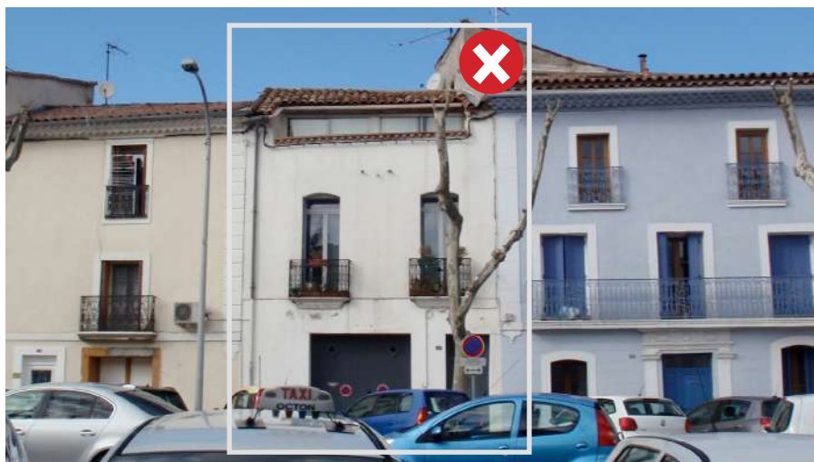
Cette terrasse aurait gagné à être accompagnée d'une pergola qui reprendrait en le complétant le rythme de la façade.
