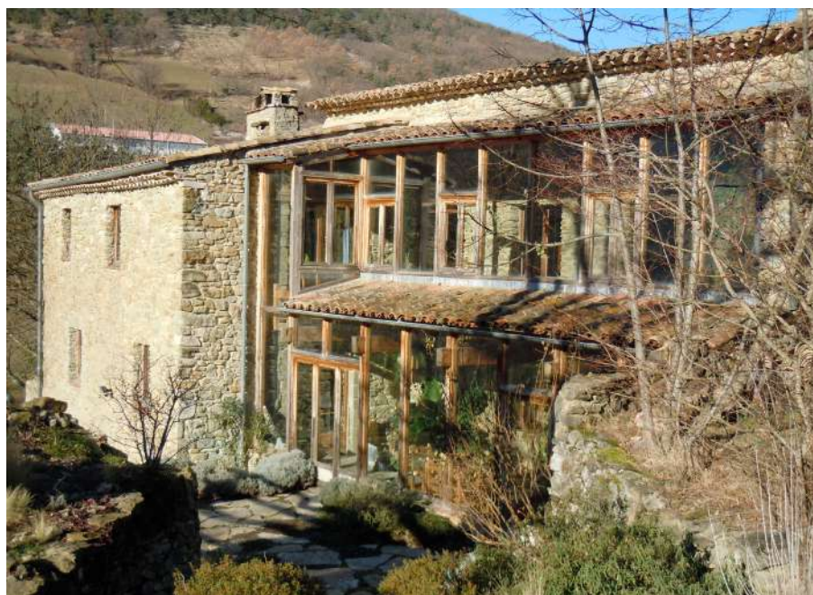
Cette transformation d'une ancienne bergerie en habitation a permis la création d'une serre sur deux niveaux, en façade Sud. En toute saison, la serre présente une température intermédiaire entre intérieur et extérieur. Drôme (26) Maître d'œuvre : O. Sidler, ingénieur.
