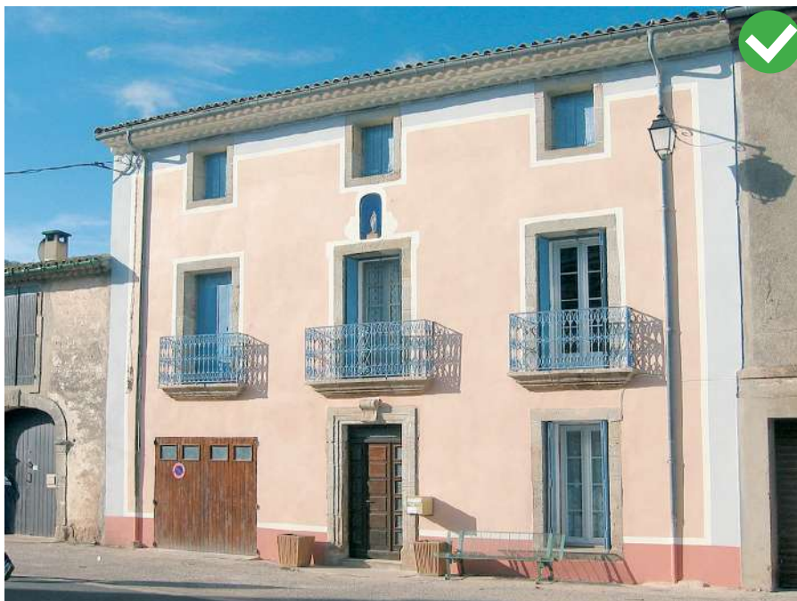
Une belle réhabilitation de façade : toutefois, les portes d'entrée et de garage auraient dû adopter la même couleur que celle des autres menuiseries...
