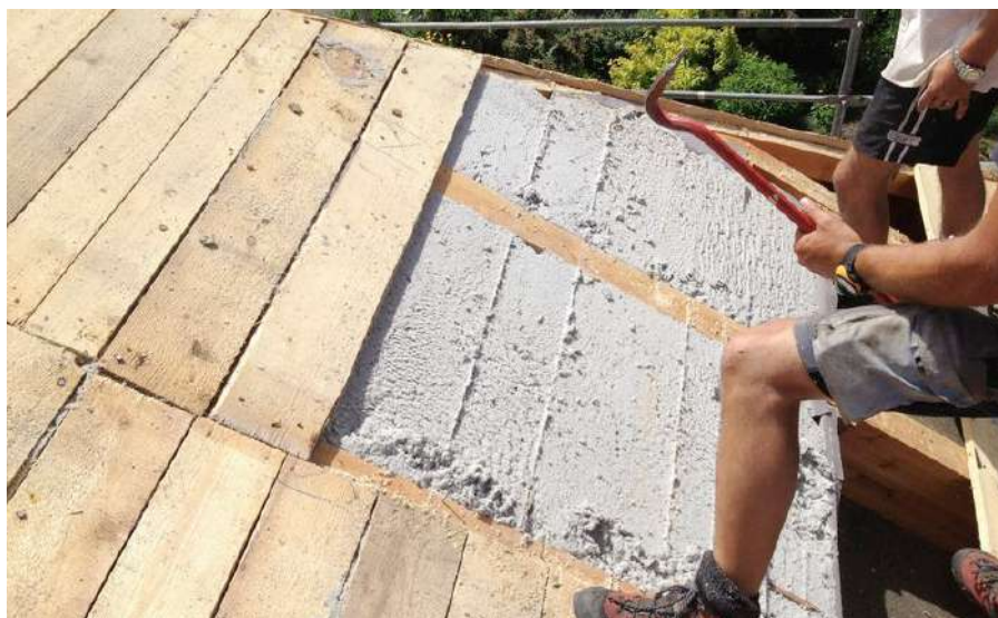
Dans cette maison témoin, 20 ans après, la ouate de cellulose est intacte.
