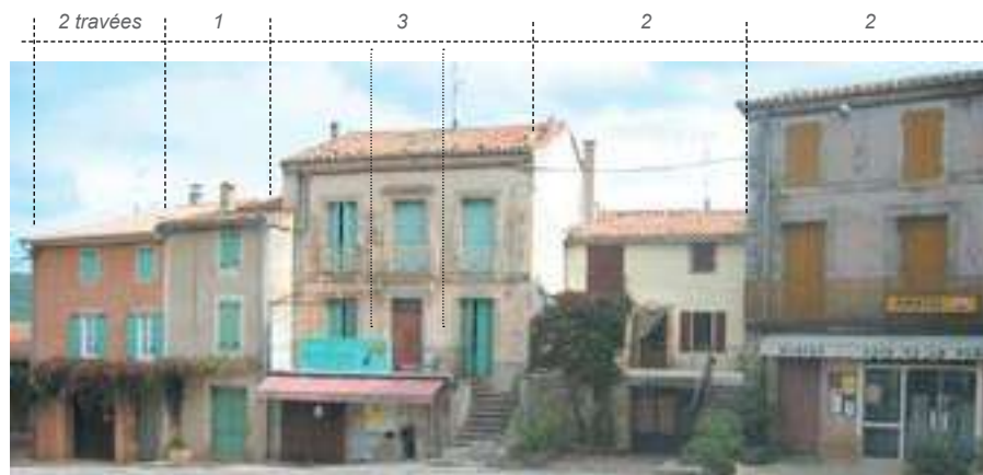
Autour de cette place de village, on distingue des maisons à une, deux et trois travées.
