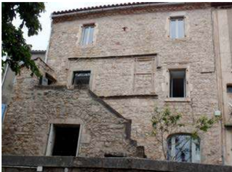
Cette façade porte de nombreux témoignages de son histoire. Dommage qu'elle ait été dénudée de ses enduits et munie de menuiseries banalisantes
