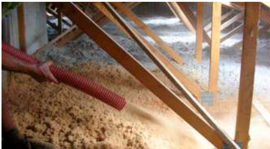
Soufflage en comble perdu de ouate de cellulose (au second plan) et fibre de bois.
