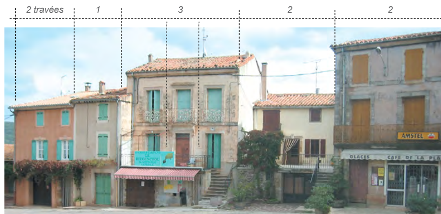
Autour de cette place de village, on distingue des maisons à une, deux et trois travées.
