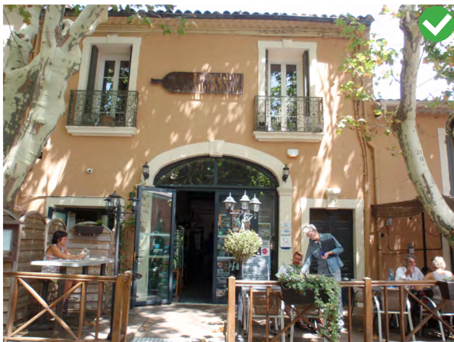
A l'exception de la couleur blanche des fenêtres du 1er étage, cette réhabilitation de façade est de qualité.
