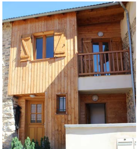
Entrée des deux logements T3 et T4
