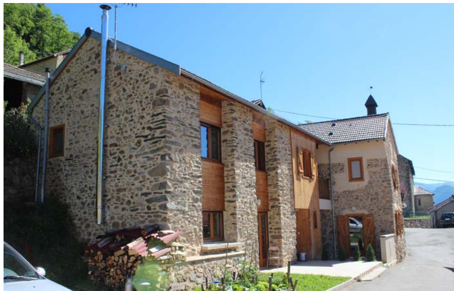
Vue générale du bâtiment après réaménagement - 1 T3 dans l'ancienne grange (à gauche) et 1 T4 dans l'ancien logement.
