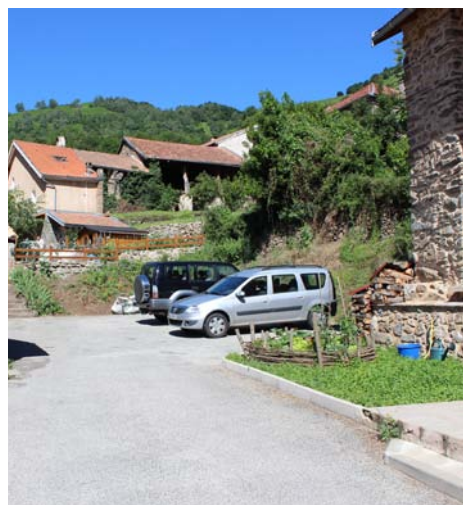
Cette opération a permis de réaliser une aire de stationnement et le désenclavement d'une parcelle privée
