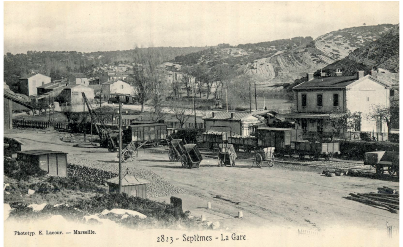
Développement urbain autour de la gare de Septèmes-les-Vallons au début du XX e siècle source : AD13 6Fi5338
