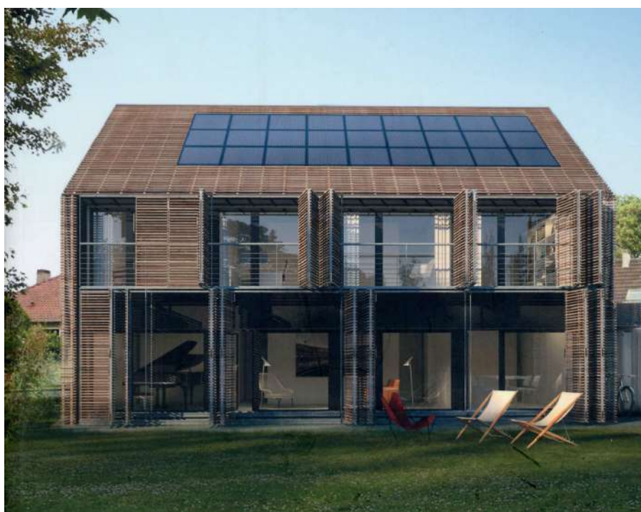
Construction d'une maison passive à Bessancourt, architectes M. Karanesheva et M. Witzmann Les capteurs solaires, thermiques et photovoltaïques sont intégrés en toiture dans un traitement homogène.
