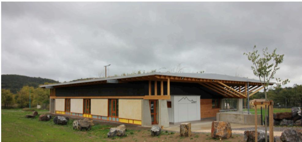
**Monoblet.** Salle, vestiaires et tribunes à Monoblet. Le projet obtient le label BDM OR. Isolation en liège, murs totem en terre-paille, charpente et ossature bois sur maçonnerie préfabriquée. Des dispositifs de frugalités énergétiques ont été mis en place: un puits climatique réchauffe ou refroidit l'air d'entrée, un poêle à pellet réchauffe cet air quand nécessaire, une tourelle à vent hybride extrait l'air vicié...
