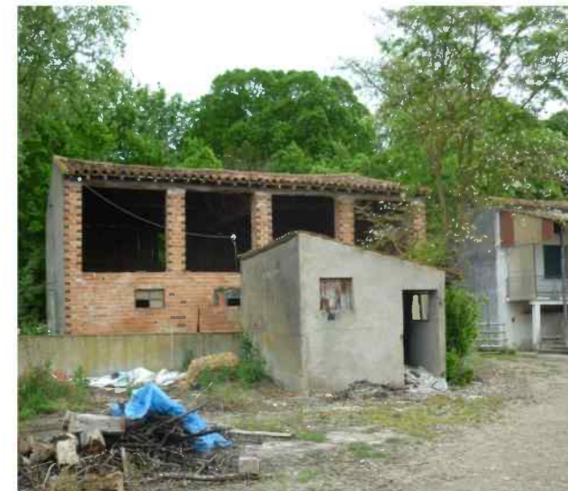
Aperçu de l'état actuel
