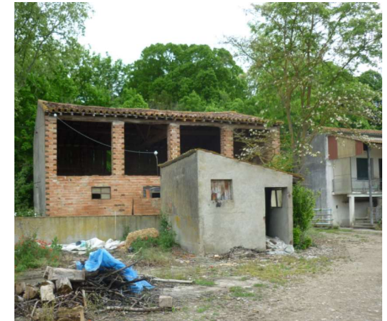
Aperçu de l'état actuel
