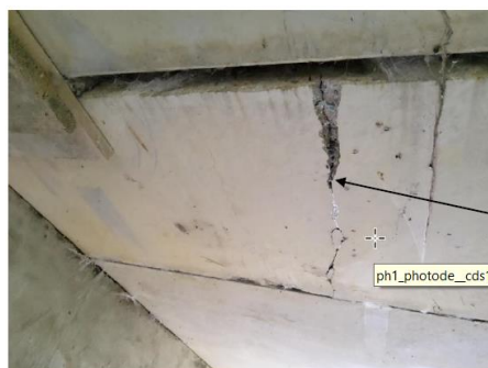
Rupture de la dalle centrale
