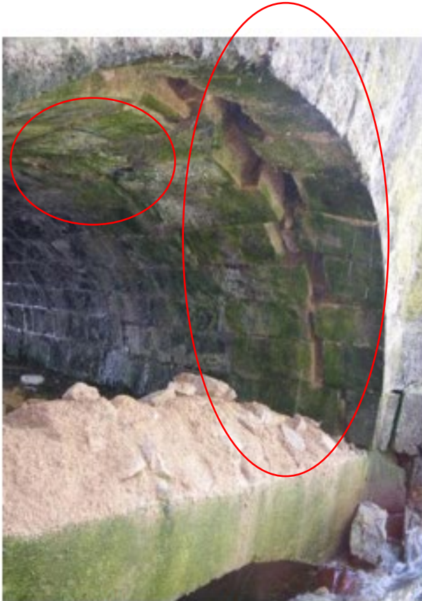
Décollement et dégradation du bandeau d'un ouvrage en maçonnerie sous l'effet de charges excentrées (absence de trottoir), puis effondrement quelque temps plus tard
