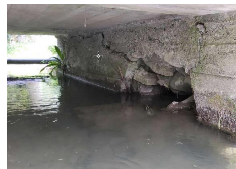
Rupture de la dalle centrale
