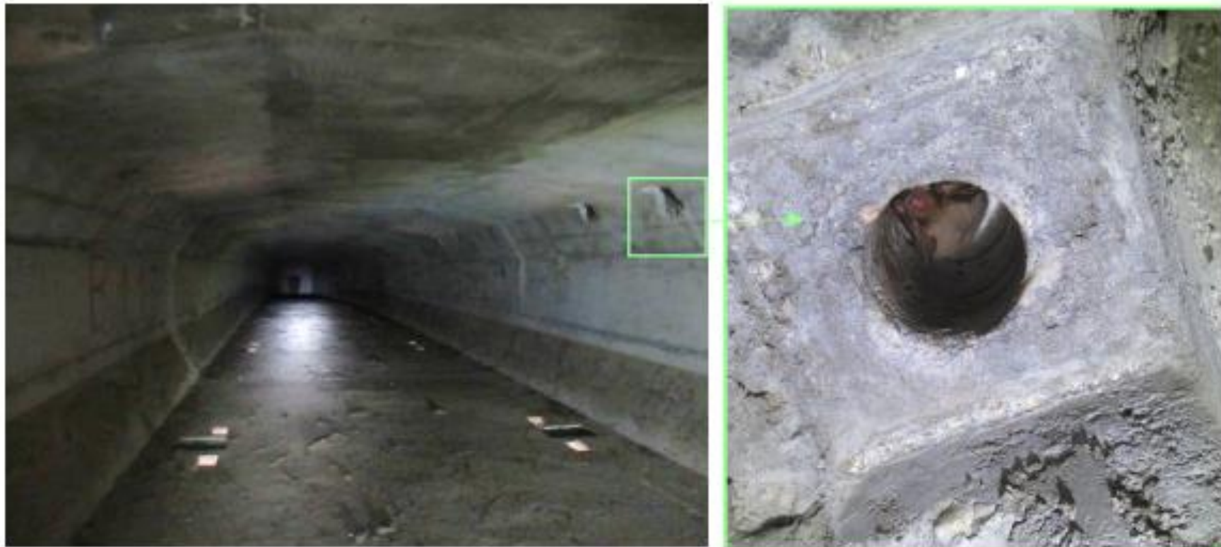
Figure 23 : Intérieur d'un caisson et illustration d'une réservation avec la présence d'un individu isolé de Murin de grande taille (Photos sur site : Naturalia)
