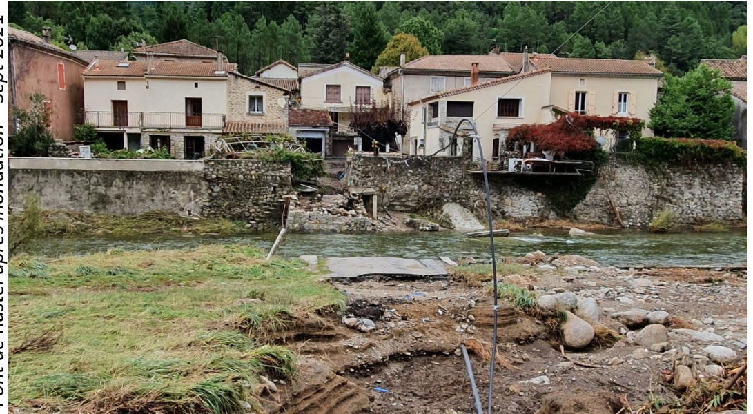
Pont de Rastel après inondation – Sept 2021
