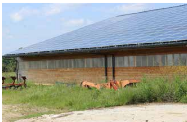
Association panneaux photovoltaïques, panneaux translucides en façade et bardage bois, dans une composition harmonieuse
