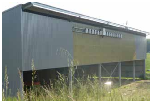
Afin de limiter l'impact d'une façade très haute qui serait ouverte, tout en respectant l'usage du bâtiment, le bardage a été mis en œuvre dans la continuité des 3 autres façades
