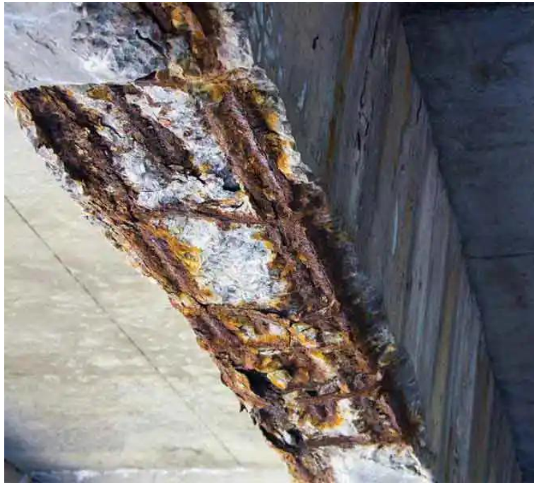
Eclats avec ou sans aciers apparents corrodés
