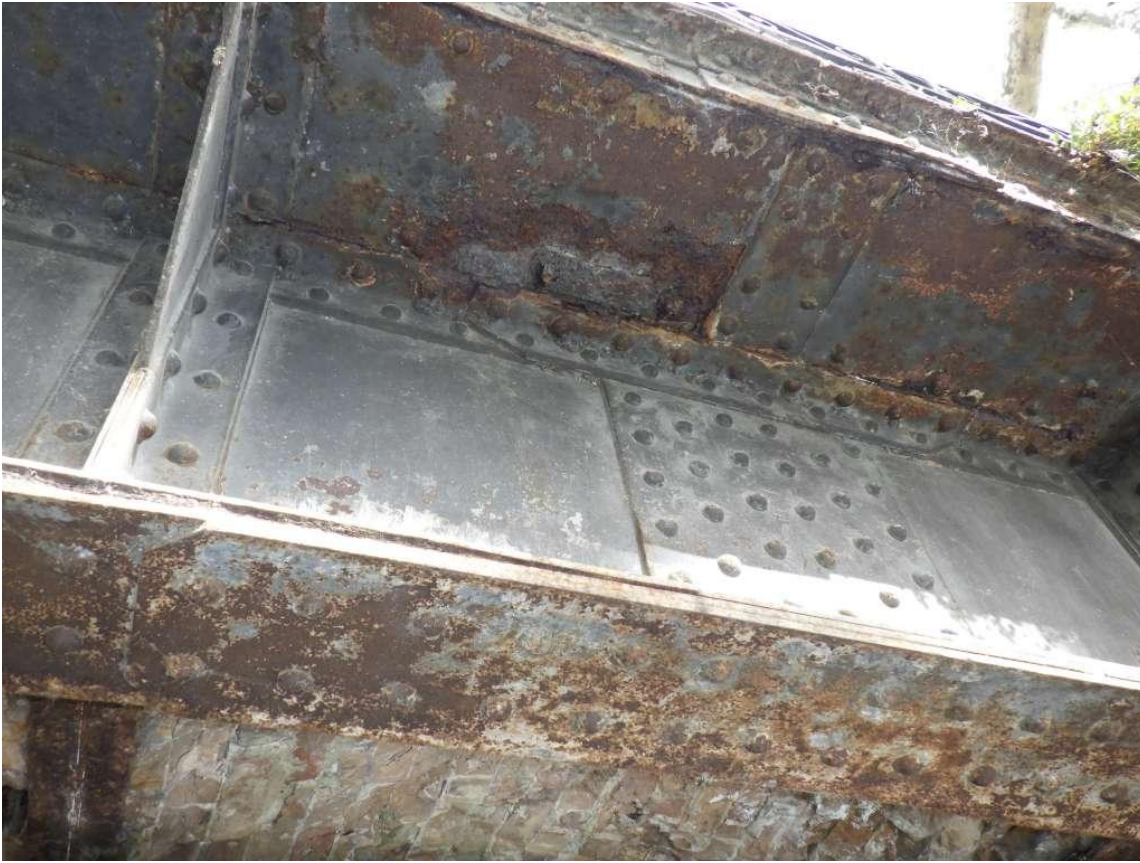
Oxydation et corrosion (foisonnant, feuilletant) des poutres métalliques
