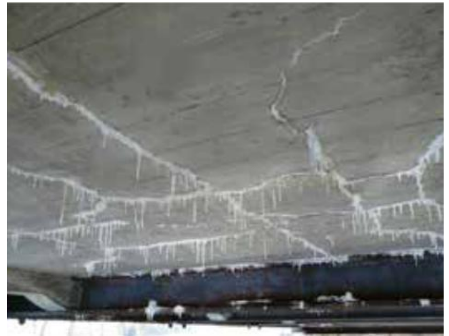
Défauts d'étanchéité, présence de concrétion
