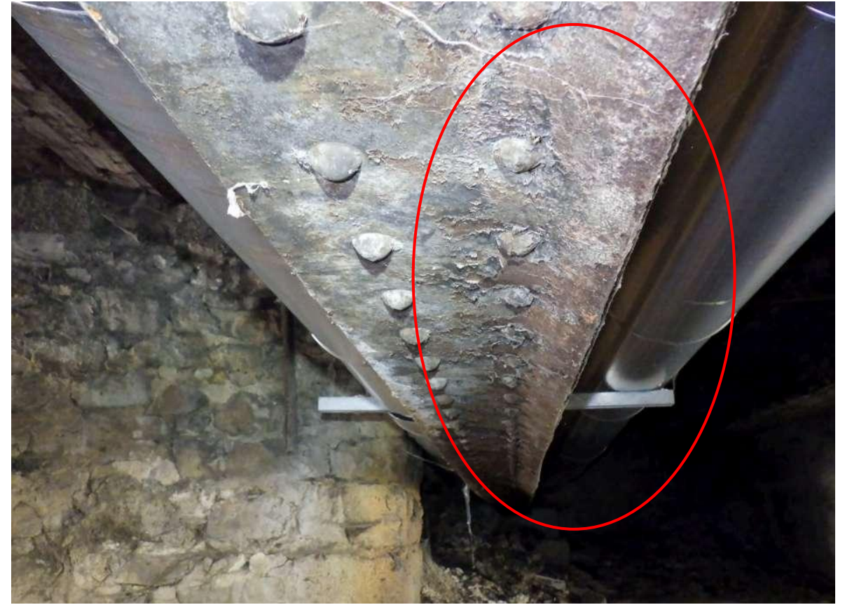
Oxydation et corrosion (foisonnant, feuilletant) des poutres métalliques
