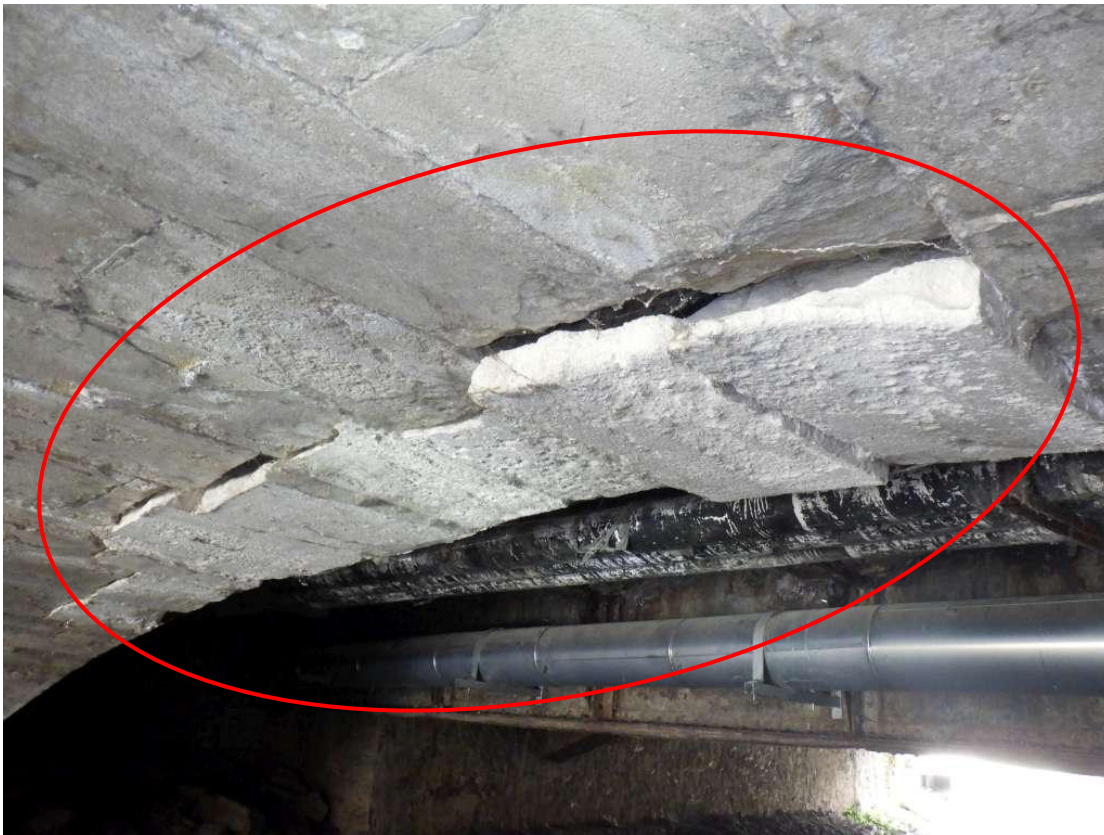
Descellement ou décollement de pierres
