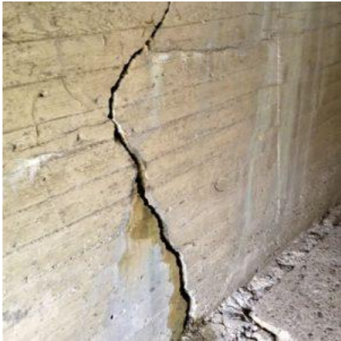
Fissuration ou fracture
