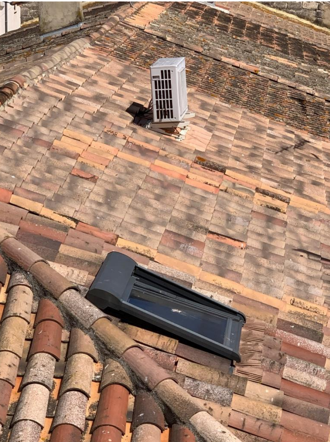
Intégration des équipements
