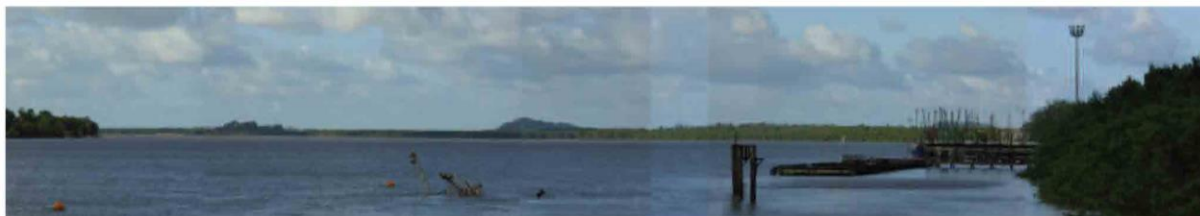
Vue du Pont Larivot
