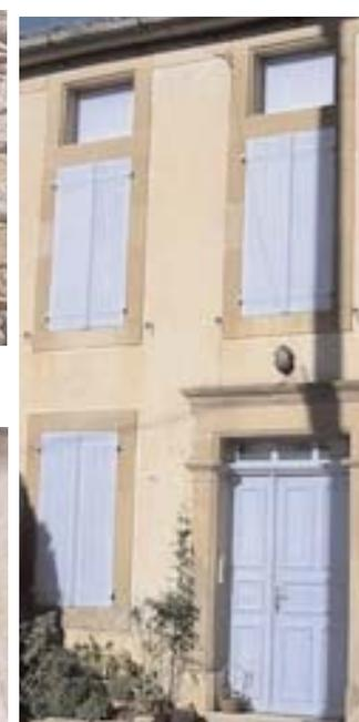
Encadrement continu en pierre entre l'ouverture de l'étage et celle du comble, Roumengoux
