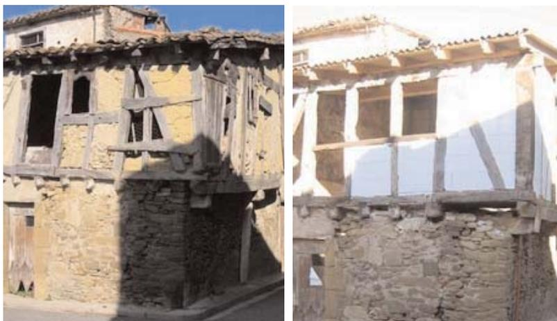
Exemple de travaux en cours de réalisation sur une maison à pans de bois. La structure a été renforcée et le remplissage en cours de réfection.
