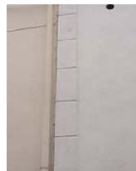
Chaîne d'angle en surépaisseur d'enduit
