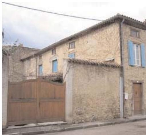
Le mur prolonge ici la maison. Réalisé avec une maçonnerie de pierre identique, il bénéficie du même enduit que la construction. Ferme, Dun
