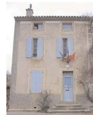
Enduit lissé réhaussé par des liserets de peinture autour des ouvertures, sur les chaînes d'angle et en bandeau sous l'avant toit, école de Belloc
