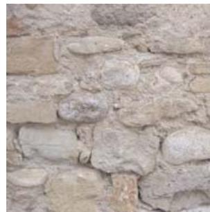
Maçonnerie de pierre, mélange de grès, calcaire et galets
