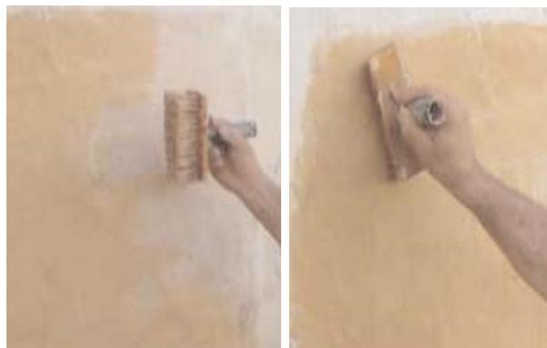
Application d'un badigeon sur un enduit à la chaux
