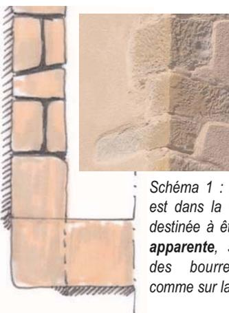
Schéma 1 : La chaîne d'angle est dans la continuité du mur, destinée à être enduite et **non apparente**, sinon cela donne des bourrelets disgracieux comme sur la photo.
