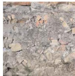
Appareillage intégrant des débris de briques.
