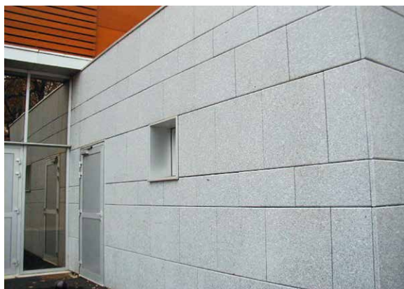
L'extension recevant la partie office, en pierre agraffée
