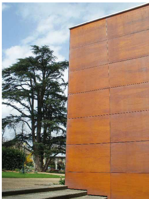
Bardage bois et isolation composite
