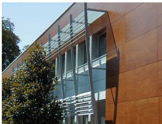
Bardage bois et brise-soleil métallique
