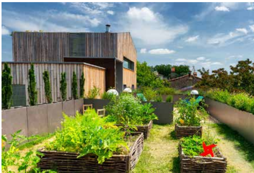
Vue de l'imbriication des volumes depuis le toit terrasse
