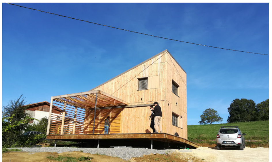
Vue de la construction depuis le chemin d'accès
