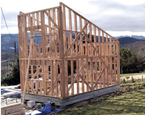
Structure en cours de chantier ossature
