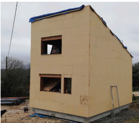
Structure en cours de chantier remplissage
