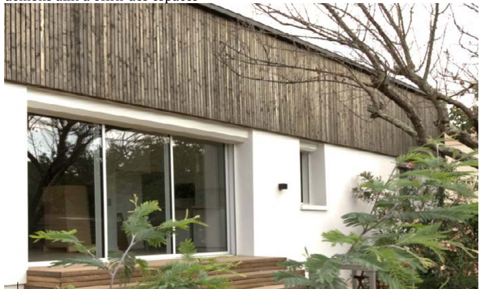
Vue de la surélévation depuis le jardin
