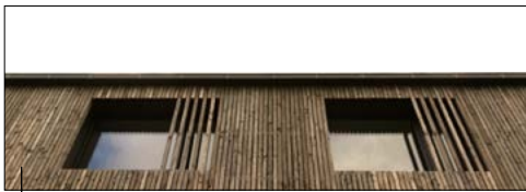
Détail du bardage en bois
