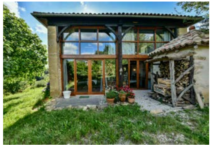
Façade Est - APRÈS travaux
