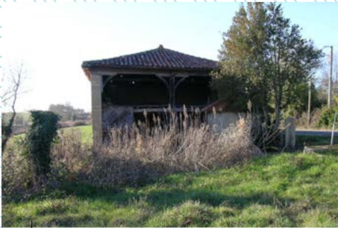
Façade Est - AVANT travaux
