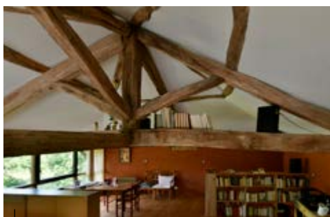
Vue de l'étage
