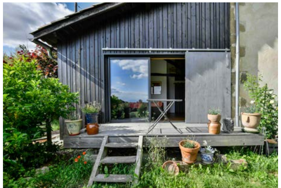
Vue de la façade Sud
