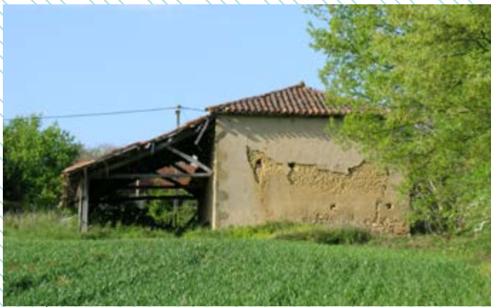
Façade Sud - AVANT travaux
