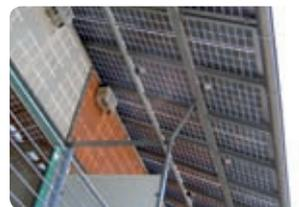
Capteurs photovoltaïques en protection solaire
