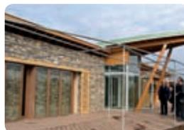
C'est une masse thermique couplée à un vitrage et séparée par une lame d'air. À lui seul, ce procédé capte l'énergie solaire, la stocke et la restitue à l'ambiance intérieure sous forme de chaleur après quelques heures.
