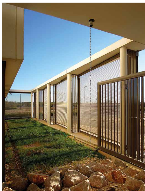
Traitement des limites
