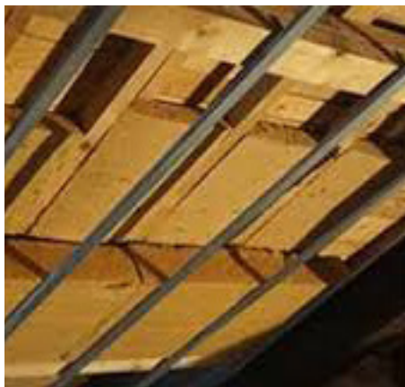
Isolation sous rampants
